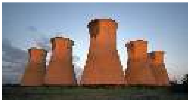
Рис. 67. Башенные гиперболические градирни с башней из монолитного железобетона
