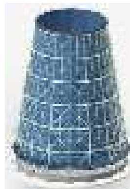
Рис. 68. Башенные градирни каркасно-обшивного типа
