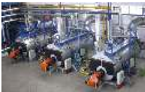
Рис. 54. Горизонтальные водогрейные котлы
