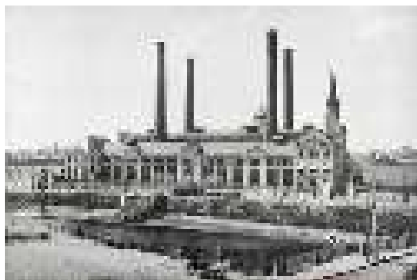
Рис. 5.3. ГЭС №1 в Москве на Раушской набережной, 1897 г.
