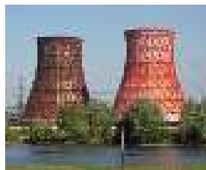
Рис. 67. Башенные гиперболические градирни с башней из монолитного железобетона
