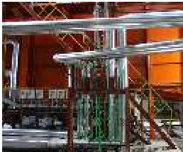
Рис. 108. Новокузнецкая ГТЭС. Интерьеры. Опознавательная окраска трубопроводов. Сигнально-предупреждающая окраска кранового оборудования. Ограждение технологических лестниц
