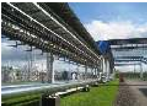
Рис. 63. Трубопроводы на эстакадах
