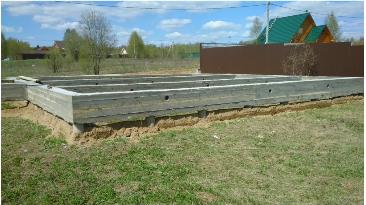
Рис. 20. Железобетонный цоколь на буронабивных сваях
