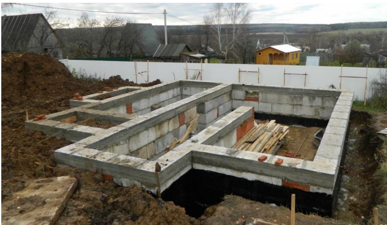
Рис. 6. Фундамент малоэтажного здания сборно-монолитного типа
