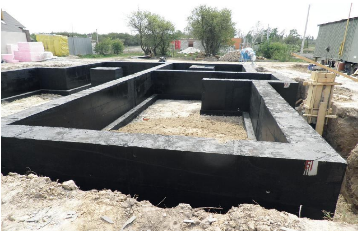
Рис. 4. Ленточный фундамент бесподвального здания
