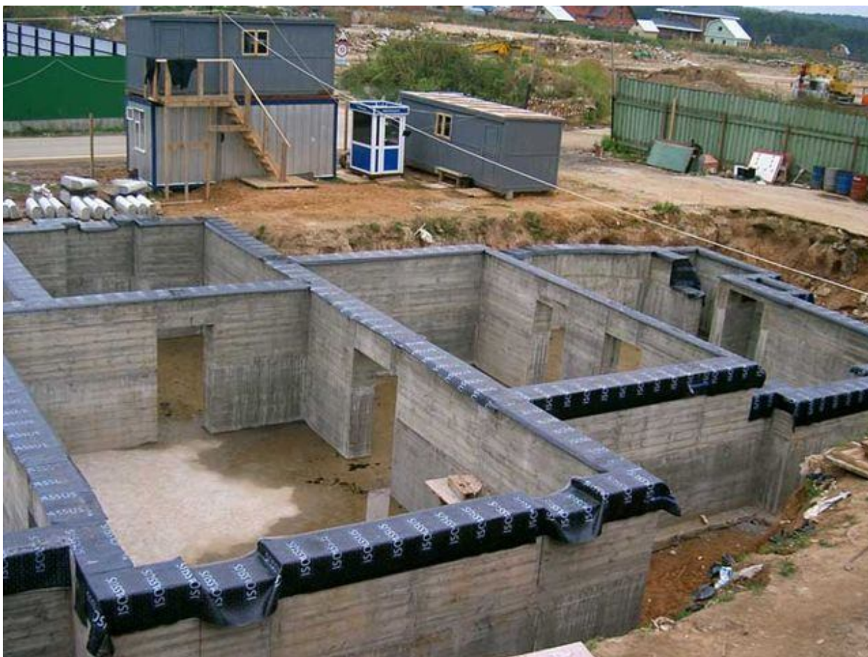
Рис. 12. Подвальный этаж коттеджа из монолитного железобетона на плитном фундаменте
