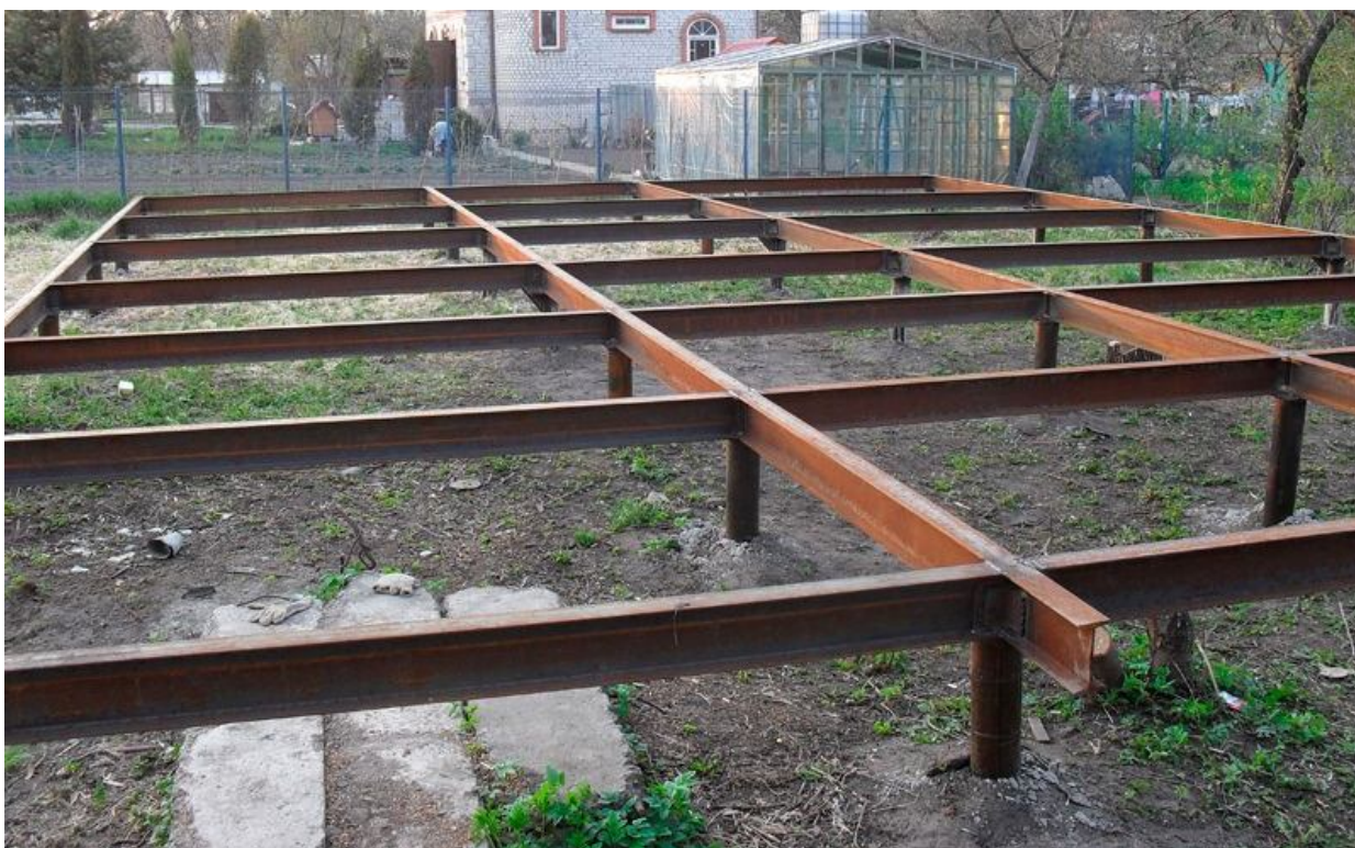
Рис. 22. Фундамент из винтовых свай и ростверк из металлопроката
