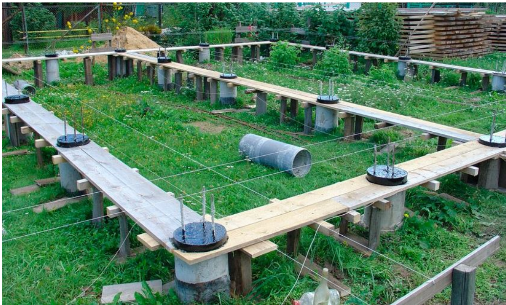
Рис. 19. Фундамент из буронабивных свай
