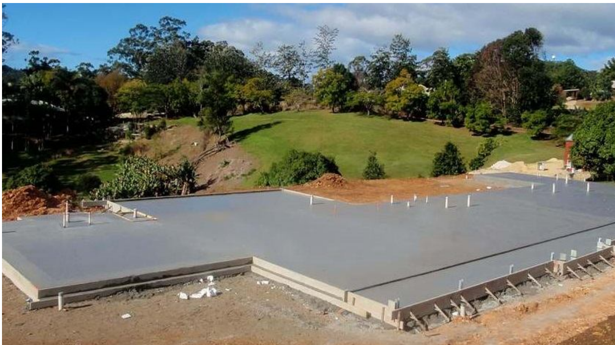
Рис. 11. Готовый плитный фундамент малоэтажного дома
