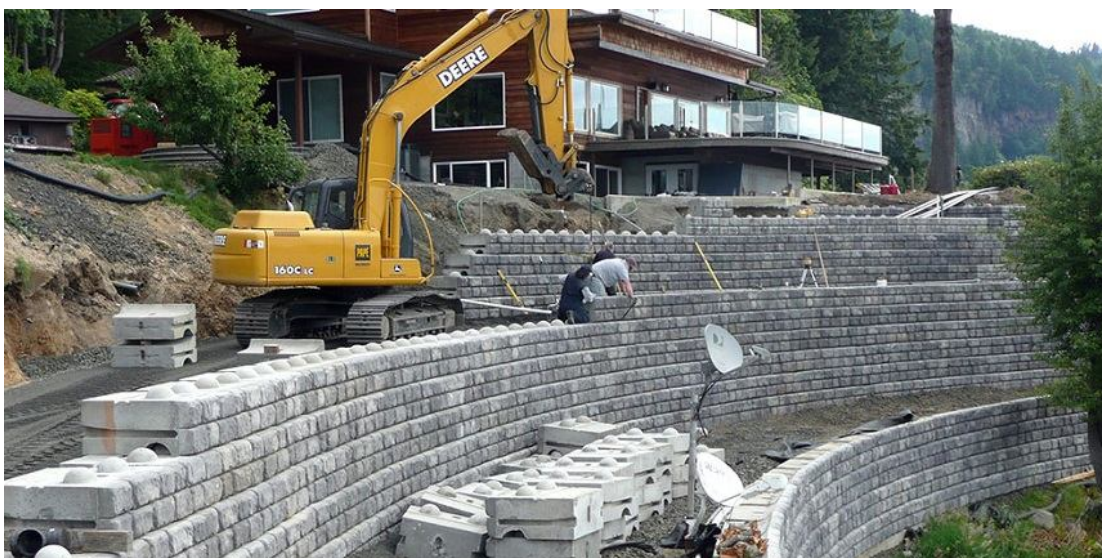
Рис. 32. Гравитационная подпорная стенка из сборных блоков
