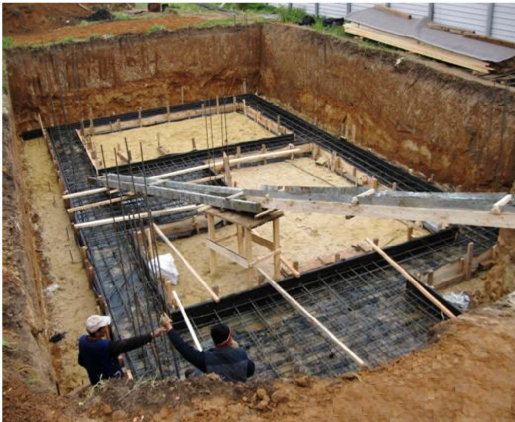
Рис. 2. Устройство опалубки и арматурных каркасов ленточного фундамента
