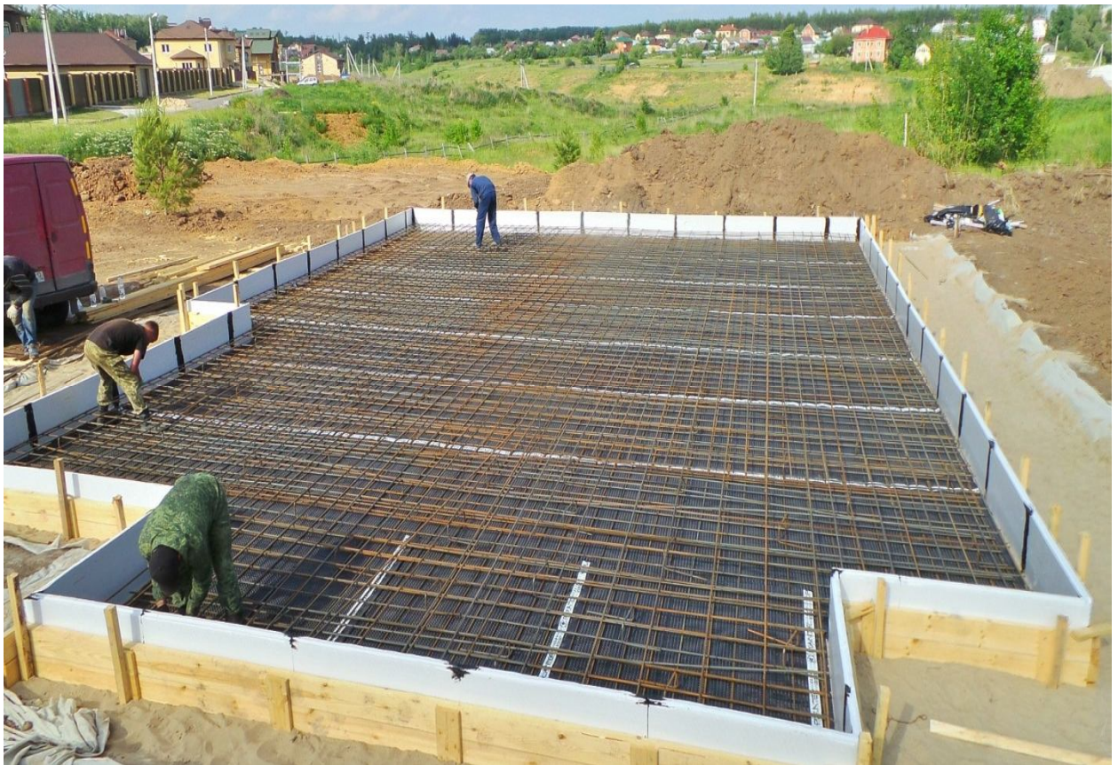
Рис. 10. Устройство арматуры фундаментной плиты мелкого заложения
