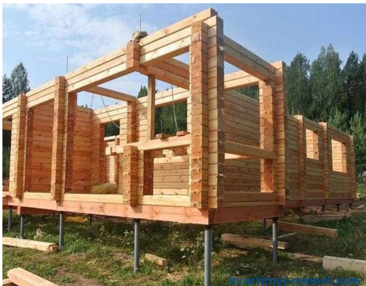
Рис. 23. Каркас здания из бруса на фундаменте из винтовых свай
