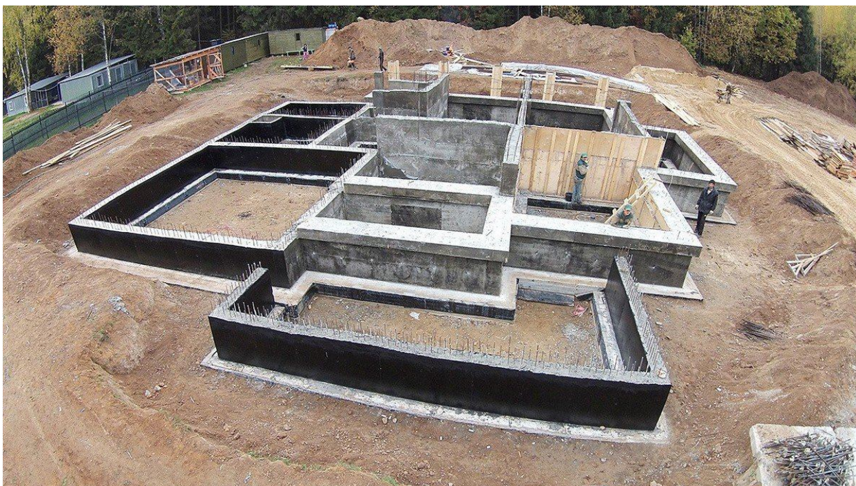
Рис. 3. Ленточный фундамент и стены подвала в процессе возведения
