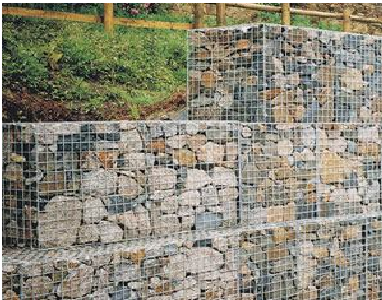
Рис. 35. Подпорная стенка из габионов в форме параллелепипеда
