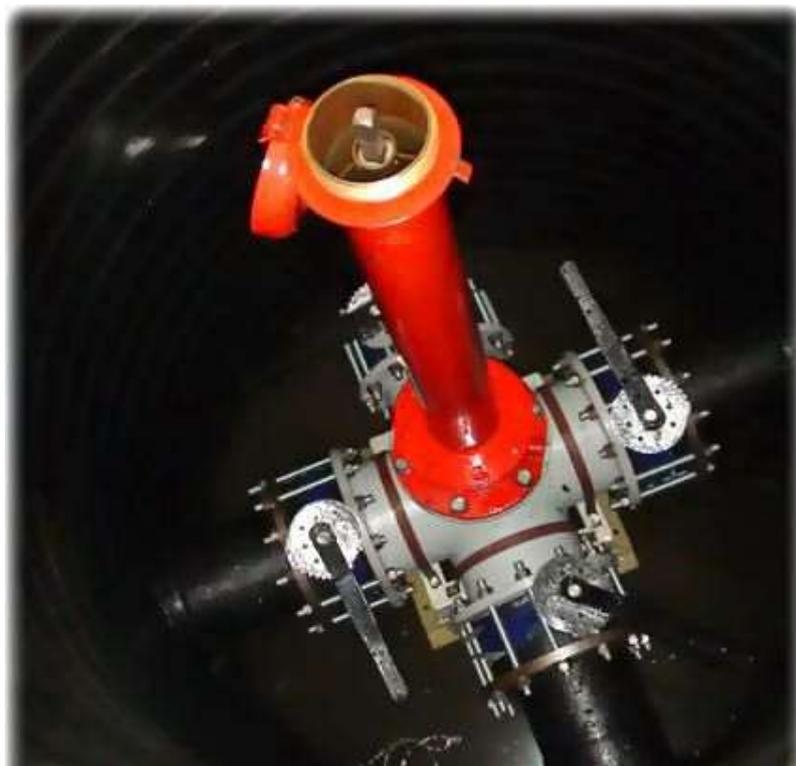
Рис. 2 Узел присоединения пожарного гидранта к городской водопроводной сети
