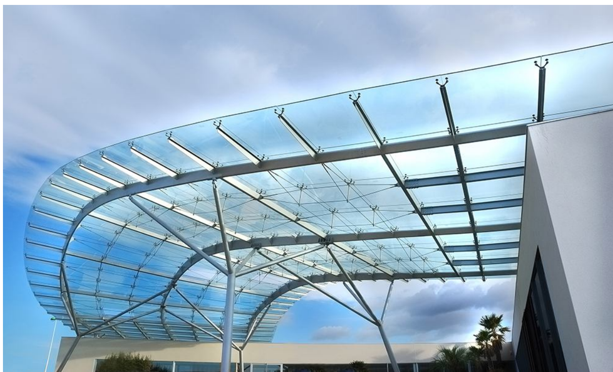
Рис. 47. Спайдерное остекление козырька входа.
