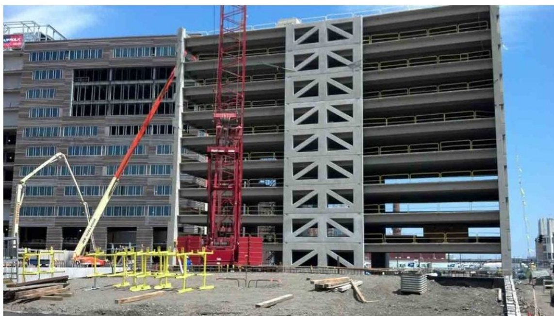
Рис. 63. Channel Center план, здание гаража во время строительства.
