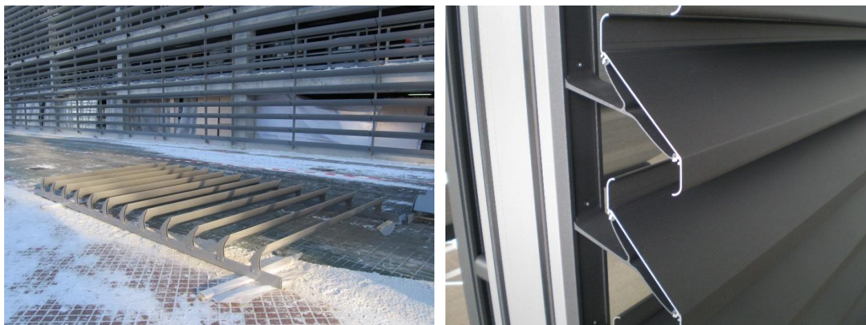
Рис. 21. Фасад жалюзи с горизонтальным расположением ламелей. Деталь.
