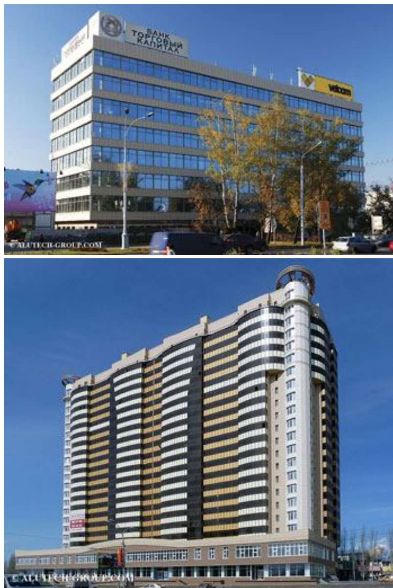
Рис. 32. Стоечно–ригельный фасад рамного остекления.
