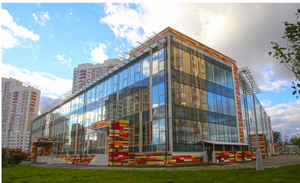
Рис. 27 Светопрозрачная фасадная система в здании школы.
