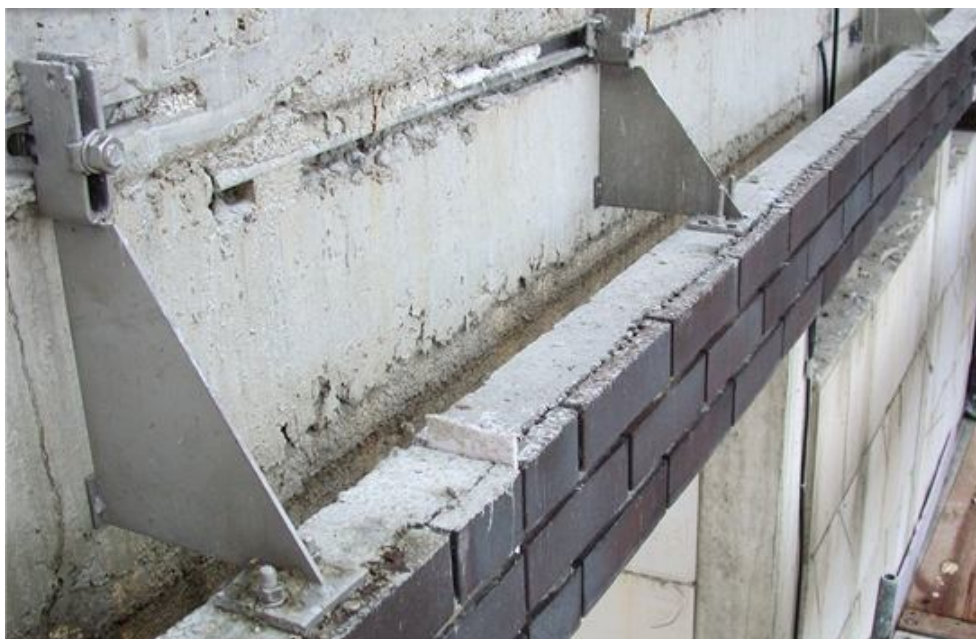
Рис 15. Фасадная система HALFEN НК4.
