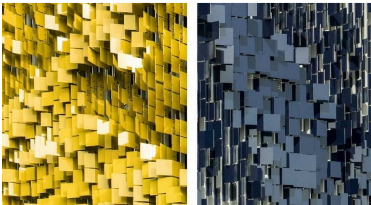
Рис. 24. Фасадные панели, с одной стороны они тёмно-синие, а с другой – ярко-золотые. Панели установлены под разными углами.
