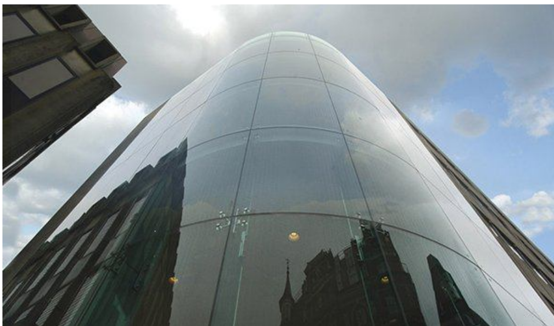
Рис. 48. Спайдерное остекление фасада.
