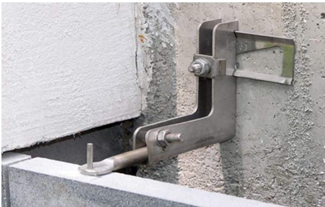
Рис 19. Система крепления HALFEN для натурального камня.
