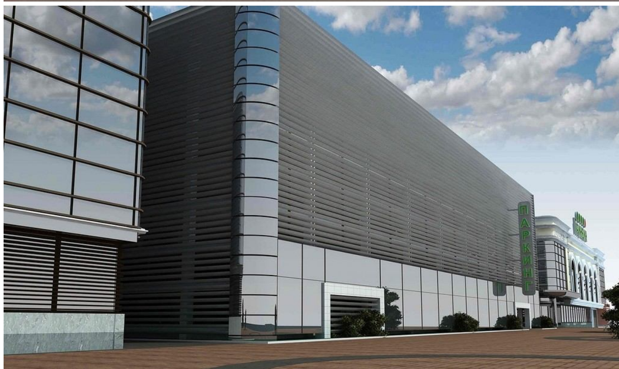
Рис. 22. Многоуровневая надземная автостоянка ТРЦ «Гринвич» (Екатеринбург) до и после реконструкции фасада. Фасадная панель.
