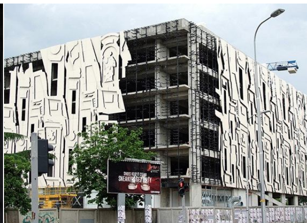
Рис. 2. Здание для автомобильной стоянки в городе Скопье (Македония), Архитектурная студия PRAG совместно с дизайнером Milan Mijalkovic. Фасад состоит из последовательно нанесённых четырёх слоёв панелей, которые были изготовлены при помощи лазерной резки.
