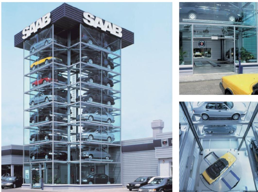
*Механизированный гараж для хранения автомобилей SAAB*
