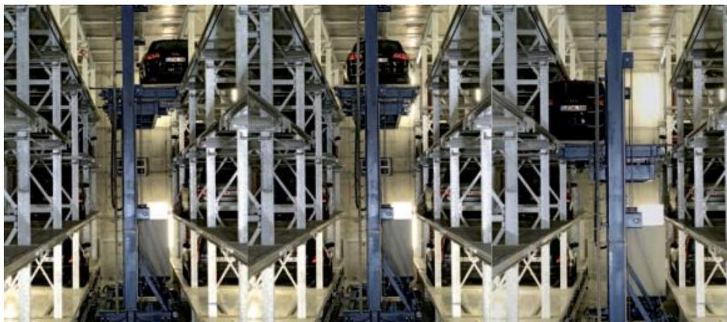
Многоэтажный автоматизированный паркинг (МАП) предназначен для постоянного и временного размещения большого количества автомобилей на небольшой занимаемой площади. Одна секция комплекса занимает участок земли размером чуть больше, чем 10х10 метров, что обеспечивает возможность монтажа в условиях плотной городской застройки.
