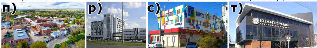
Рисунок 2.12. Примеры зданий производственного назначения
