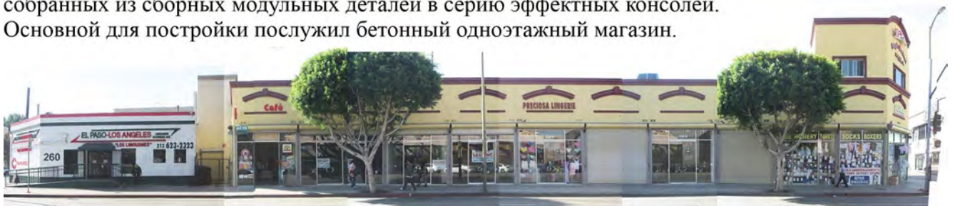
Вид здания до реконструкции под жилую функцию.
