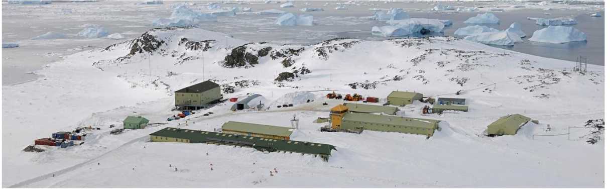
станция Зуккелли (Италия)
