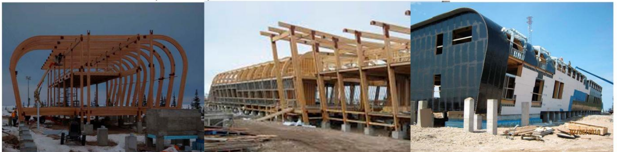
Сборка аэродинамического объема станции
