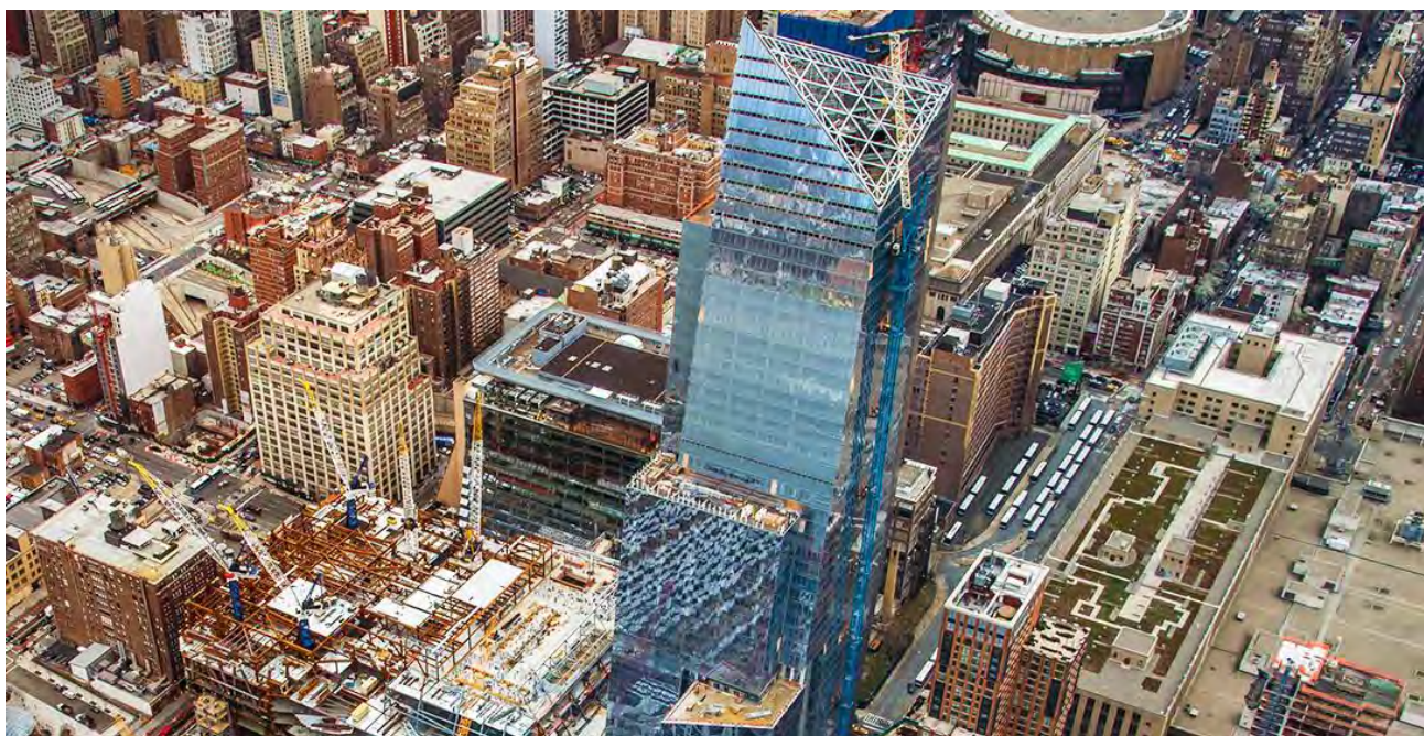
Рисунок 203. Вид на строительную площадку комплекса Сады Гудзона, Нью-Йорк, США
