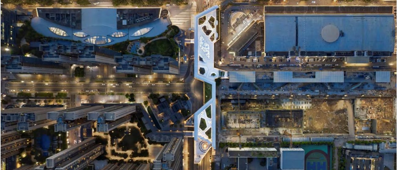
Рисунок 59. Платформенный мост. Вид сверху. Лонганг, Шэньчжэнь, Китай. Архитектурное бюро FCHA, 2020 год
