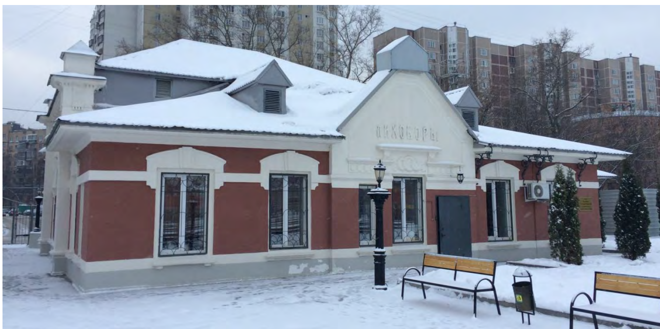
Рисунок 18. Станция Лихоборы. Пассажирское здание. Современное. Автор фото: Крылова И.
