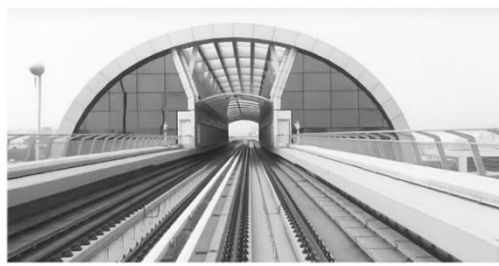
Рисунок 8. Станции с береговыми платформами со стенами в междупутье по оси станции и различными по форме проёмами: а) станция «Стахановская»; б) станция «Давыдково»; в) станция «Окская»; г) станция «Юго-Восточная»; д) наземная станция в Дубае
