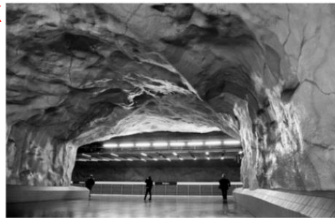
Рисунок 10. Станция «пещерного» типа метрополитена в Стокгольме, Хельсинки
