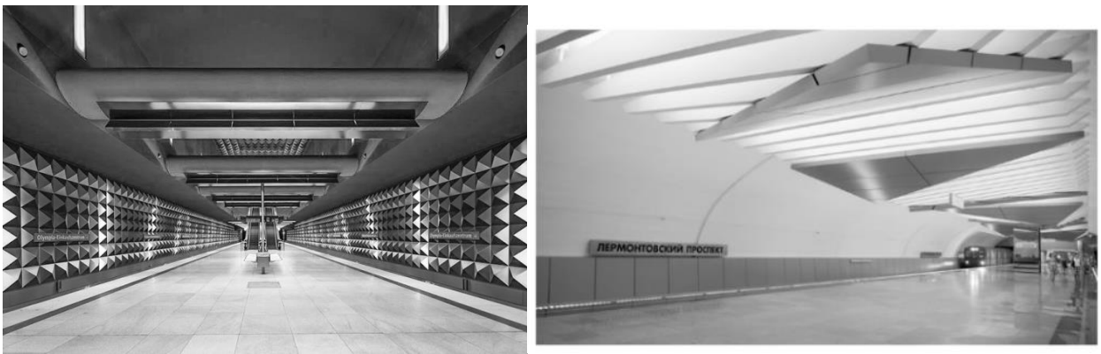
Рисунок 64. Шумоподавляющие стеновые панели, акустические подвесные потолки: а) станция «Олимпийский центр», Мюнхен; б) станция «Лермонтовский проспект», Москва
