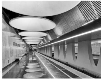
Рисунок 8. Станции с береговыми платформами со стенами в междупутье по оси станции и различными по форме проёмами: а) станция «Стахановская»; б) станция «Давыдково»; в) станция «Окская»; г) станция «Юго-Восточная»; д) наземная станция в Дубае
