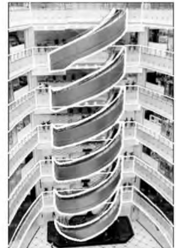
Рисунок 46. Эскалаторные ходы, атриумы: а) эскалаторный ход на станции «Ицхак Навон» в Иерусалиме; б) архитектурные решения эскалаторного хода на станции «Парк Победы» в Москве и на второй линии в Варшаве; в) вестибюли с применением винтовых лестниц; г) схема наклонного лифта и спирального эскалатора; д) вестибюль со спиральным эскалатором; е) общий вид винтового эскалатора (молл «Ист Наньцзин Роад», Китай)
