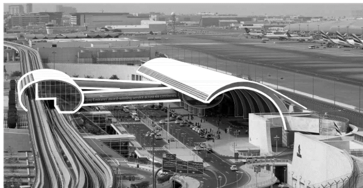
Рисунок 23. Совмещение станции метрополитена и аэровокзала в Дубае
