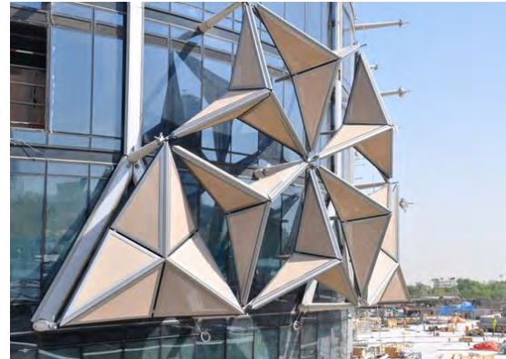
Рис. 20. «Шанхайская башня». Структура внешне оболочки (экзоскелета).
