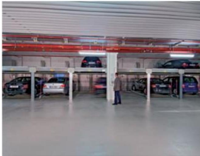
Рис. 22. Полумеханизированная автостоянка
