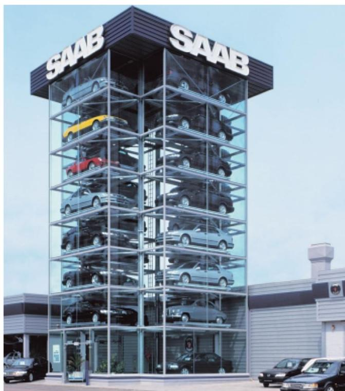
Рис. 3. Механизированный гараж для машин SAAB
