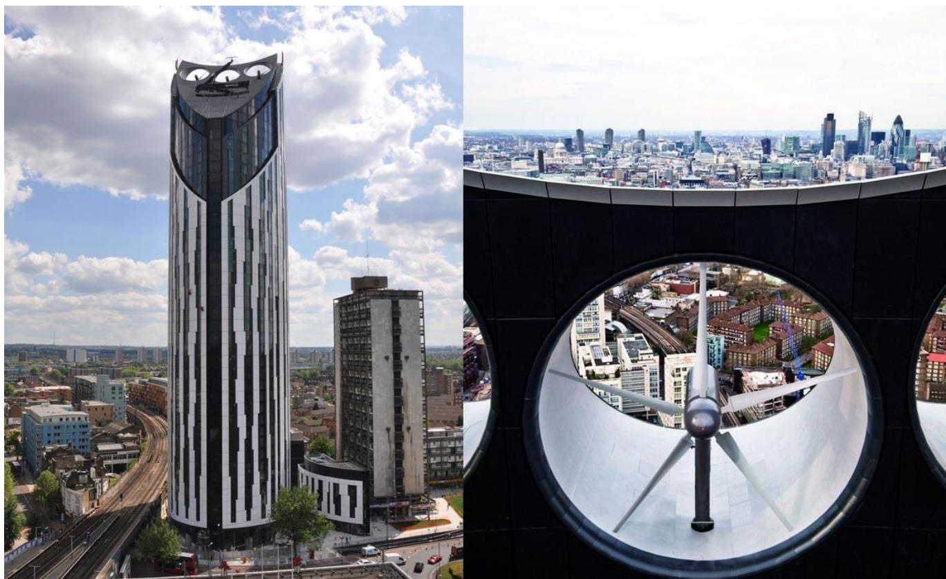
Рис. 11. Общий вид высотного здания "Башня Страта". Отверстие с энергогенератором в верхней части объекта
