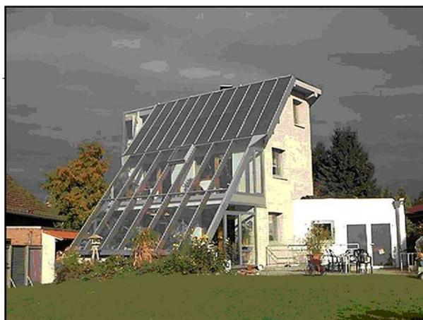
Вышеуказанный дом построен из строительных материалов с теплоизоляционными свойствами выше средних, для подогрева воды в доме используются солнечные коллекторы, а для обогрева помещений – пассивный солнечный нагрев
