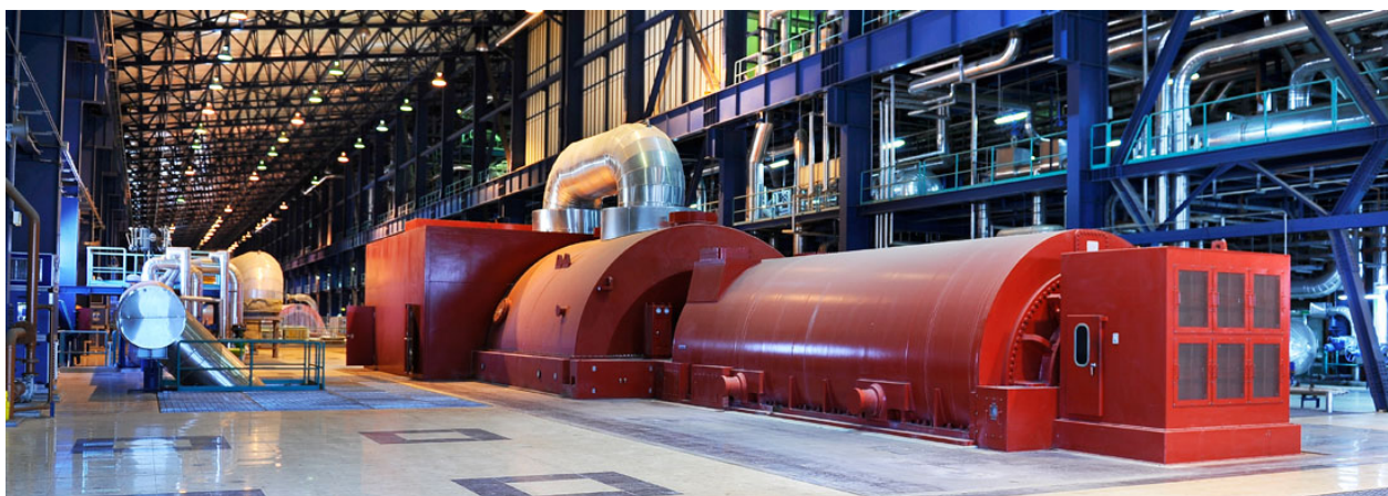
Рис. 51. Пример продольного расположения турбин
