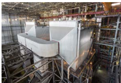
Электрофильтры для очистки дымовых газов
