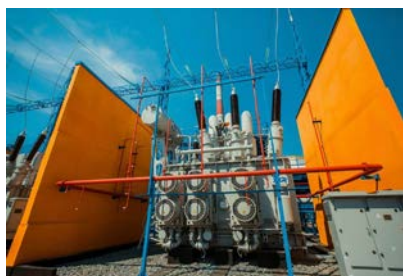
Рис.57. Трансформаторные устройства ОРУ
