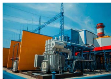
Рис. 56. Здание закрытого распределительного устройства (ЗРУ) – слева и трансформаторные установки открытого распределительного устройства (ОРУ) – справа
