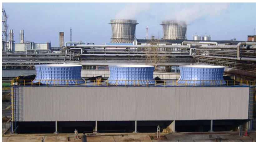
Рис. 70. Вентиляторные секционные эжекторные градирни. Справа – поперечный разрез
