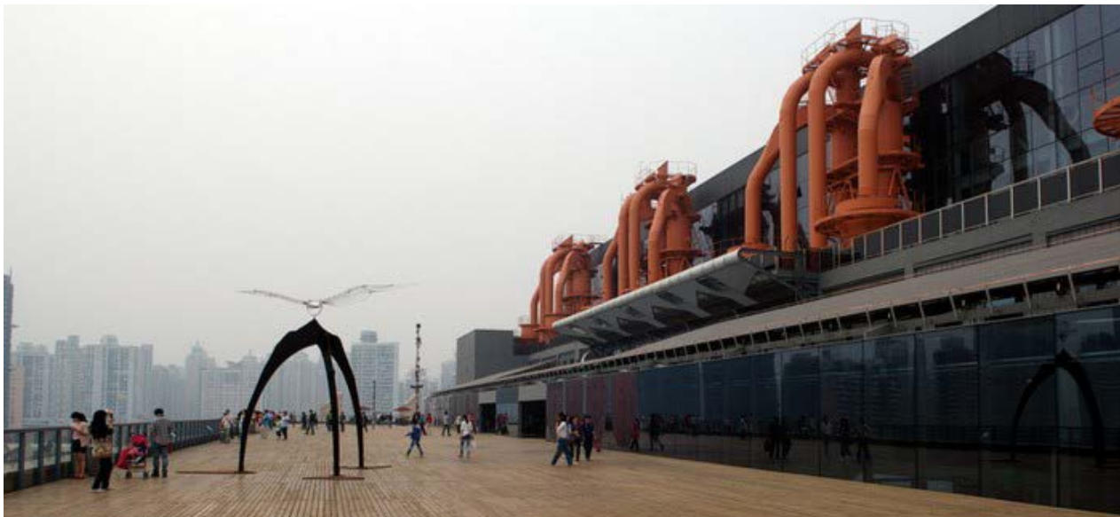
Рис. 102. Фасад бывшего котельного отделения с деревянным настилом на площадке для открытой экспозиции на кровле турбинного зала угольной ТЭЦ в Шанхае
