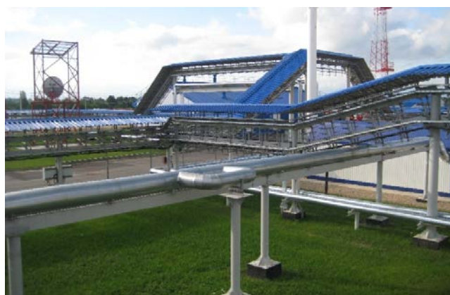
Рис. 63. Трубопроводы на эстакадах
