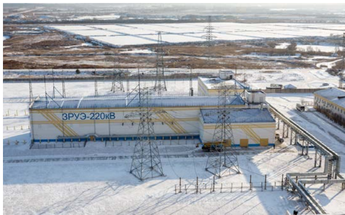
Рис. 56. Здание закрытого распределительного устройства (ЗРУ) – слева и трансформаторные установки открытого распределительного устройства (ОРУ) – справа
