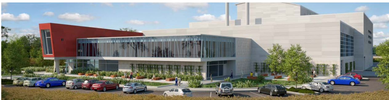
Рис. 90. ТЭЦ Голландский энергетический парк (Holland Energy Park) [20] на природном газе мощностью 145 МВт [20] в г. Голландия, штат Мичиган, США, 2017 г.
