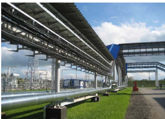
Рис. 63. Трубопроводы на эстакадах
