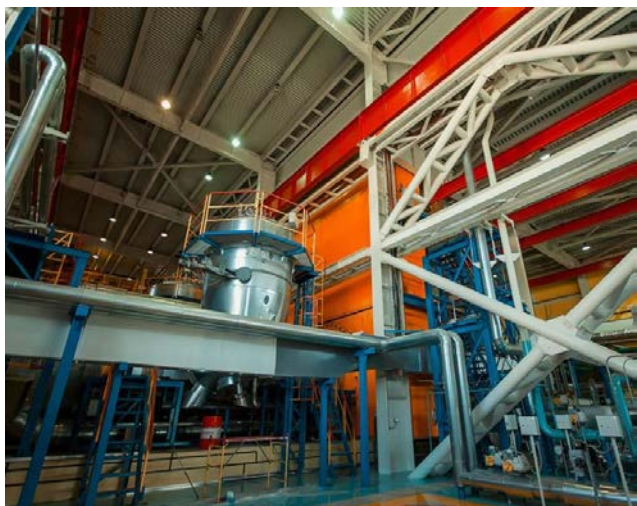
Рис. 108. Новокузнецкая ГТЭС. Интерьеры. Опознавательная окраска трубопроводов. Сигнально-предупреждающая окраска кранового оборудования. Ограждение технологических лестниц
