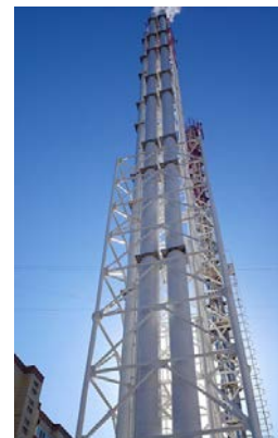
Рис. 66. Примеры архитектурно-конструктивного решения промышленных дымовых труб
