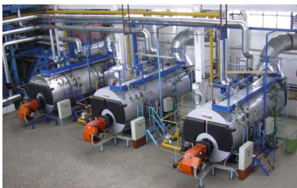
Рис. 54. Горизонтальные водогрейные котлы
