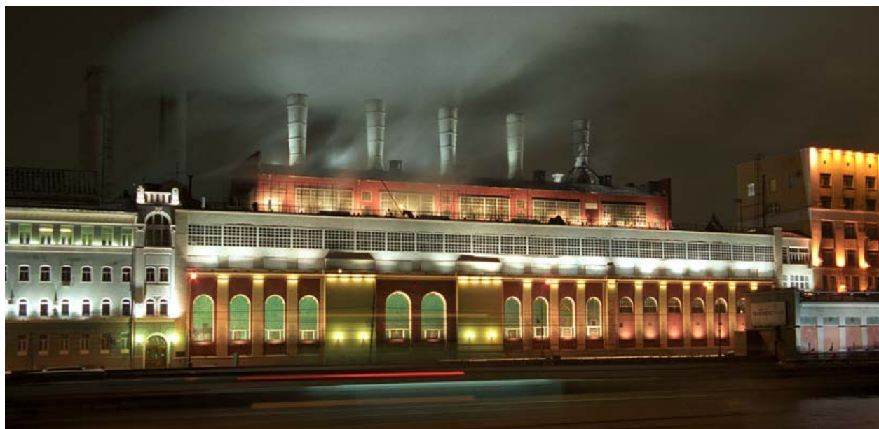
Рис. 6.2. ГЭС №2 в Москве на Болотной набережной, 1905-1907 гг. Ночное освещение
