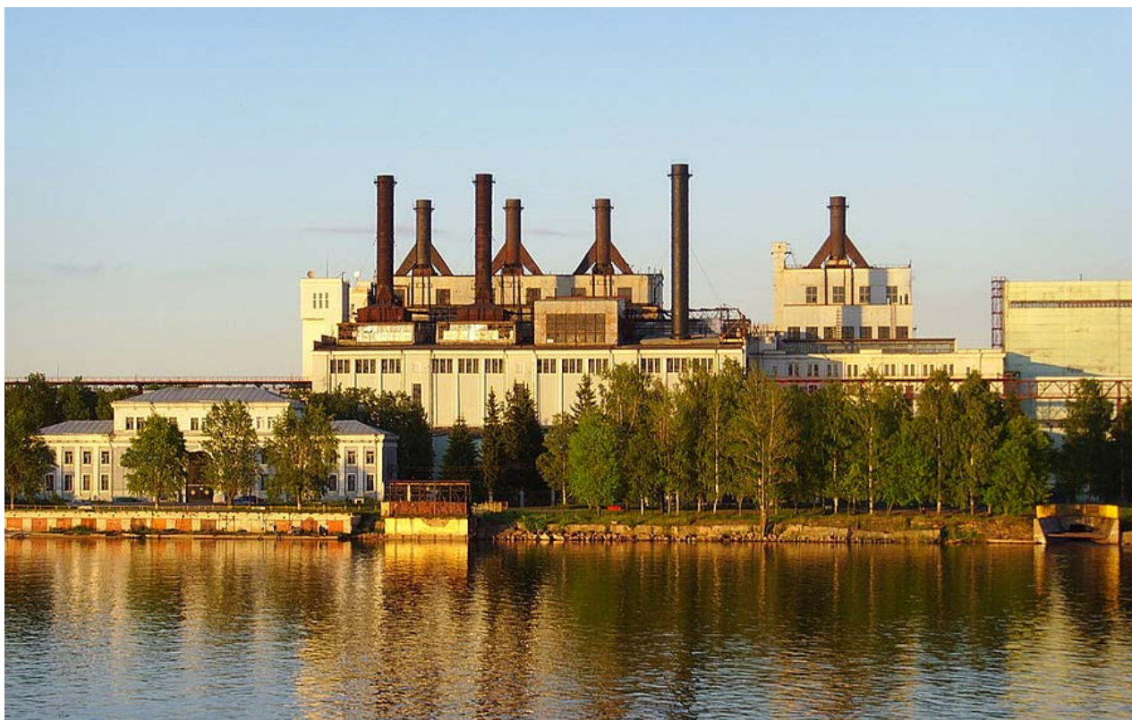
Рис. 8. Дубровская ТЭЦ, Ленинградская область, построена в 1933 г.
