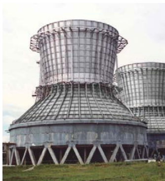
Рис. 69. Одновентиляторная градирня СК-400
