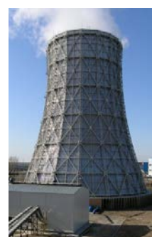
Рис. 67. Башенные гиперболические градирни с башней из монолитного железобетона
