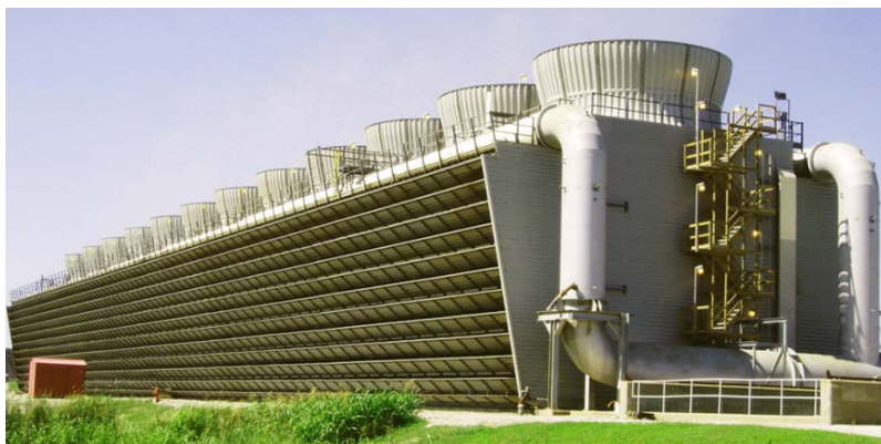
Рис. 69. Одновентиляторная градирня СК-400
