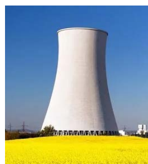
Рис. 67. Башенные гиперболические градирни с башней из монолитного железобетона
