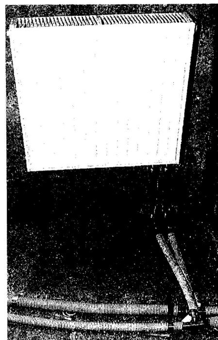
Рис. 15 Присоединение отопительного прибора при двухтрубной схеме
