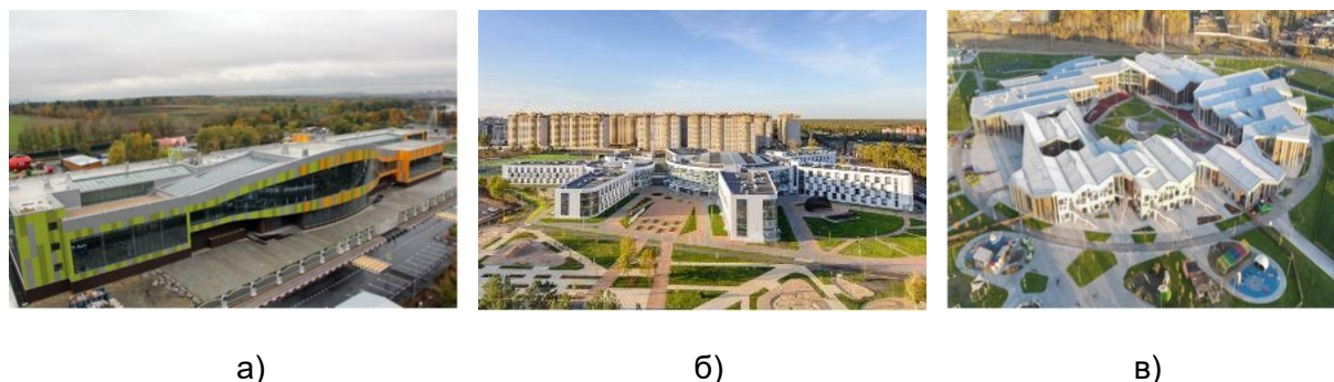
Рис. 4. Возведенные школы на территории РФ: а) инженерный корпус школы № 548 «Царицыно»; б) ОЦ «Содружество»; в) школа «Точка будущего»
