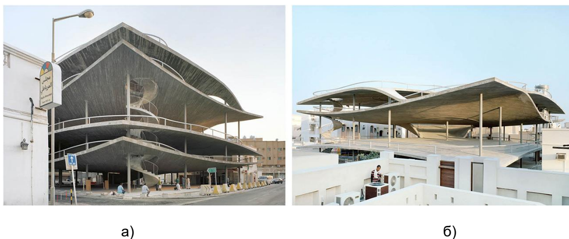
Рис. 7. Многоуровневые парковки, Кристиан Керец, 2023 г.: а) вид с улицы; б) вид с крыши соседнего здания
