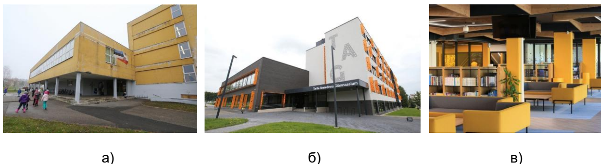
Рис. 6. Аннелинская гимназия: а) фасад здания гимназии до реконструкции; б) фасад здания гимназии после реконструкции; в) фрагмент интерьера после реконструкции
