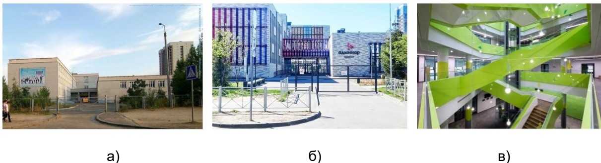
Рис. 7. Здание школы №165 «Адымнар»: а) фасад здания школы до реконструкции; б) фасад здания школы после реконструкции; в) фрагмент интерьера после реконструкции – внутренний атриум
