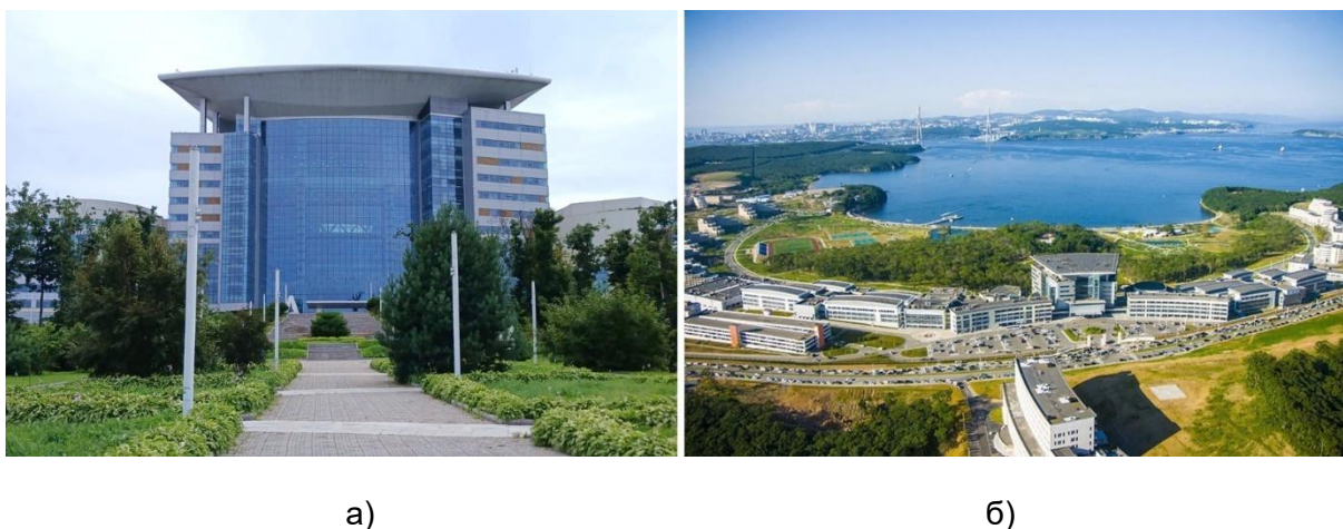
Рис. 3. Кампус Дальневосточного федерального университета: а) фасад центрального корпуса ДВФУ со стороны парка; б) общий вид на кампус ДВФУ
