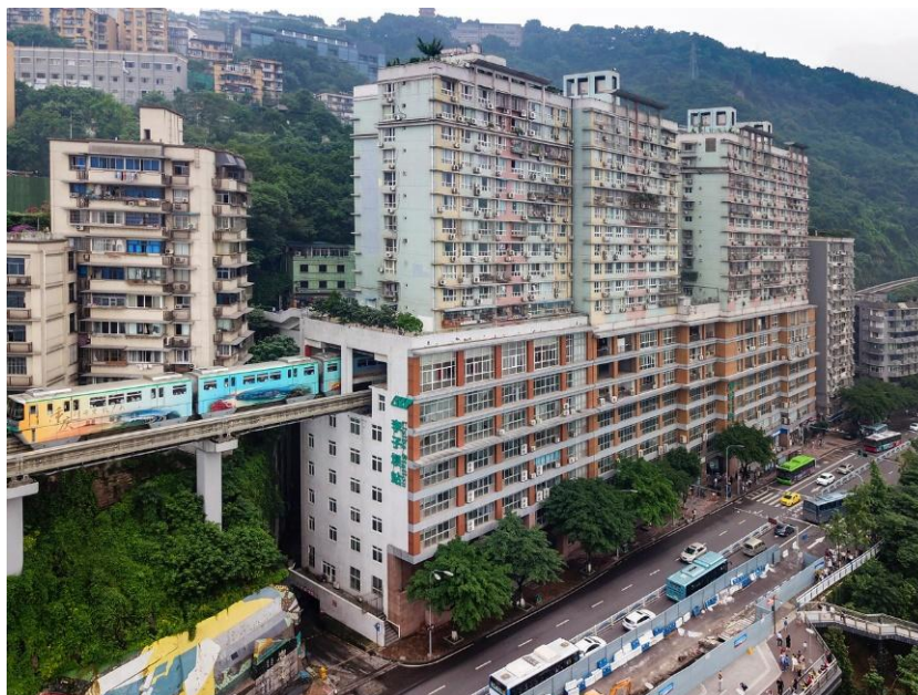
Рис. 1. Станция Лицзыба в Чунцине
