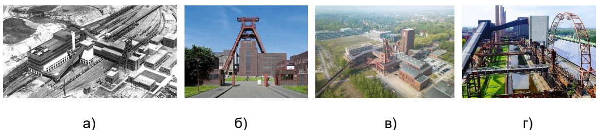
Рис. 2. Комплекс Цольферайн, Эссен, арх. Фриц Шупп, Мартин Креммер: а) строительство Шахты 12. Историческая фотография 1930-х гг.; б) вид на главный копер Шахты 12. Современное состояние; в) общий вид на территорию комплекса Шахты 1, 2, 8. Современное состояние; г) общий вид на батарею коксовых печей. Современное состояние
