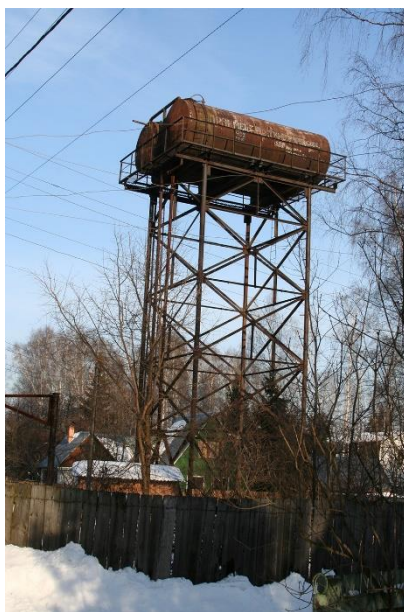
Рис. 1. Водонапорная башня СНТ «Текстильщик», Богородский городской округ, Московская область
