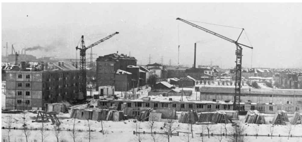
Рис. 7. Монтаж 64-х квартирного крупнопанельного дома по ул. Химиков, 1967 г.
