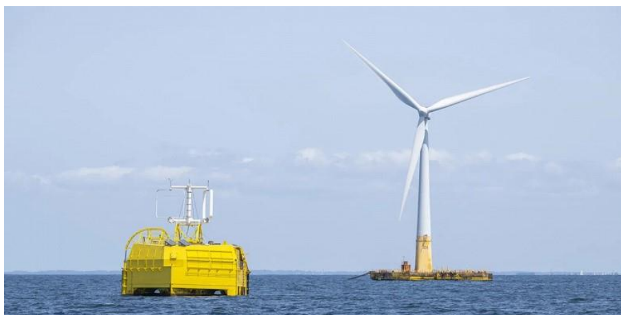
Рис. 3. Установка по производству водорода, Ле-Круазик, Франция
