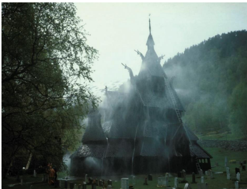
Рис. 3. Деревянная церковь Боргунд, Согн, Норвегия, во время испытания спринклерной системы пожаротушения в 1982 году
