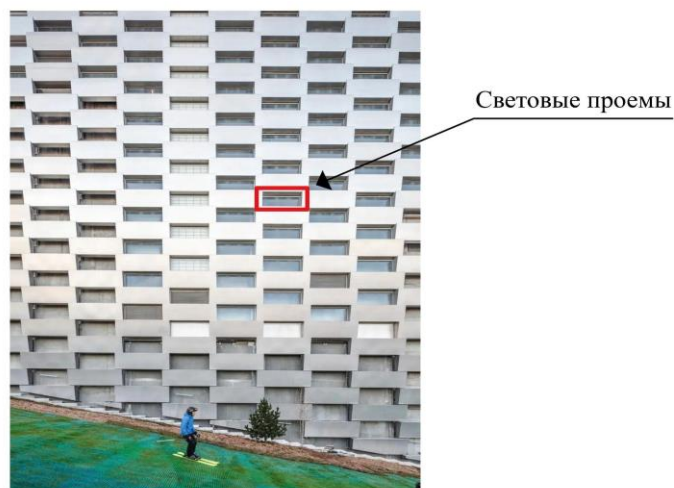
Рис. 2. Юго-западный фасад СоренHill, имеющий световые проемы
