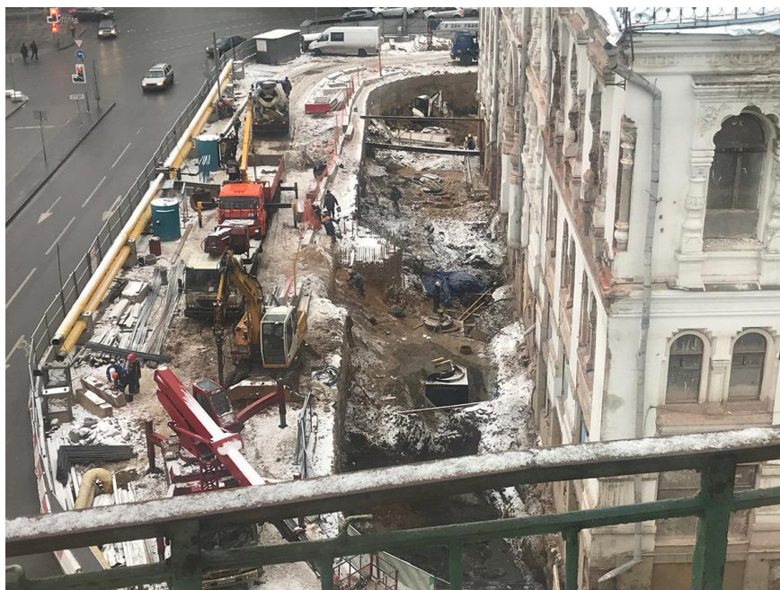
Рис. 7. Политехнический музей. Процесс раскрытия цоколя южного торца здания
