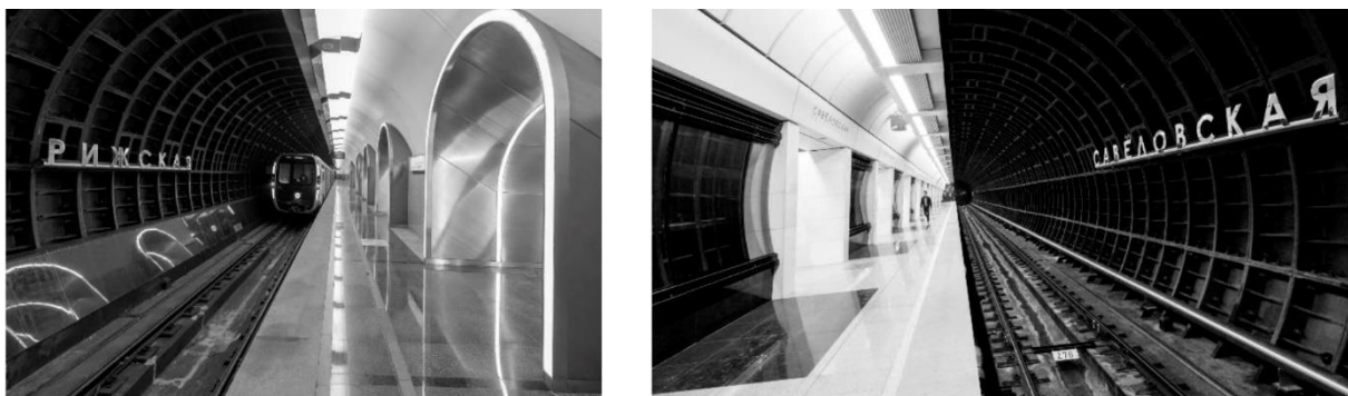
Рис. 2. Раскрытие обделки путевых стен на станциях «Савёловская» и «Рижская»
