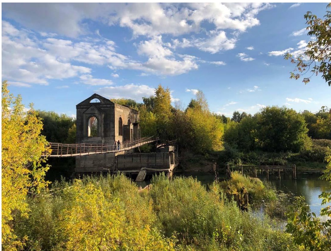
Рис. 1. Современное состояние прибрежной территории реки Нерль у ГЭС «Петровская» 1953 года постройки
