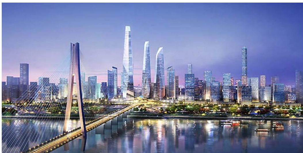
Рис. 2. Вантовый городской мостовой переход Эрци (8 полос движения (по 4 в обе стороны, обеспечивающих транспортным средствам скорость 60 км/ч) как элемент Второй кольцевой автодороги и архитектурной композиции, обслуживаемый тремя линиями метро и инновационной сетью скоростного автобусного сообщения с пешеходным доступом от этого инженерного сооружения до центрального делового района в прибрежной зоне г. Ухани (КНР)
