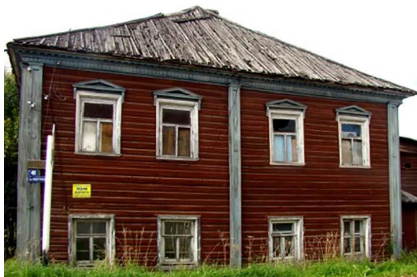
Рис. 5. Дом М.А. Красавина. Построен в начале XX в., Архангельская обл., г. Каргополь, ул. Ленинградская, 20
