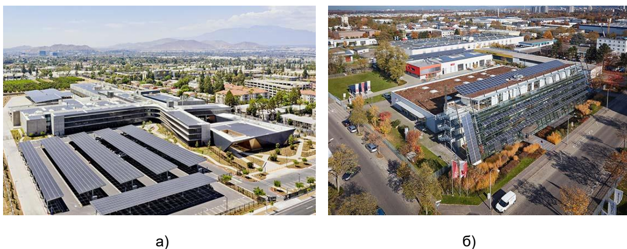
Рис. 2. Научно-производственные комплексы. Различная степень выраженности фотоэлектрической системы: а) скрытая система . Испытательный центр CARB; б) видимая система . Научно-производственный корпус M10 Solar Campus
