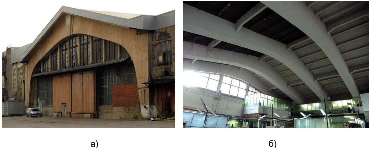
Рис. 7. «Ангар №7» на территории завода «РСК «МиГ»: а) северный фасад; б) интерьер
