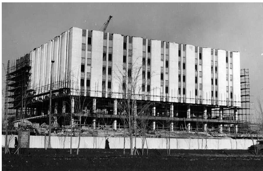
Рис. 3. Процесс строительства здания ИО РАН (1970-е годы)
