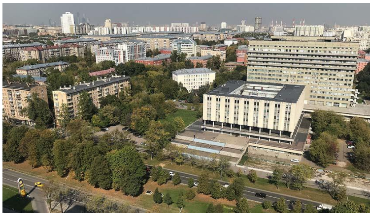
Рис. 9. Панорамный вид на существующее здание ИО РАН и прилегающую территорию, отведенную под строительство будущего нового здания
