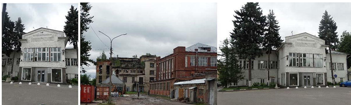
Рис. 9. Современное состояние центрального фасада и основных сооружений фабрики
