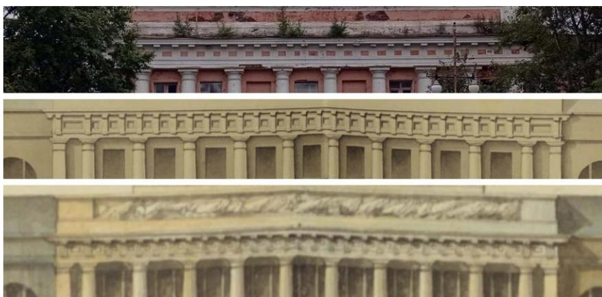
Рис. 10. Тригфлы антаблемента ГК. Вверху – фото; в центре – чертеж 1835; внизу – чертеж 1810 г.
