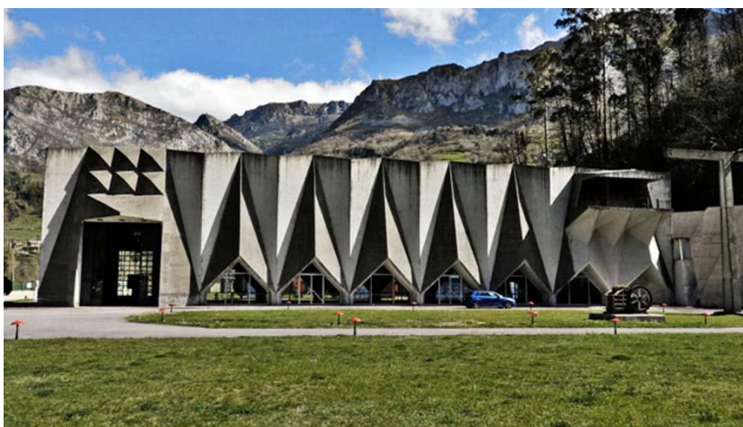
Рис. 6. Proaza Power Plant, Испания, 1964 г. Архитектор: Хоакин Вакеро Паласиос
