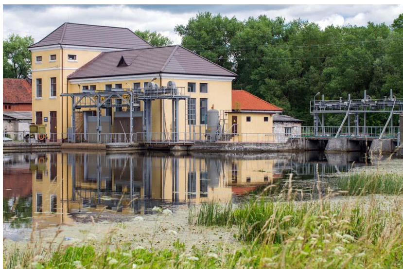
Рис. 1. Озёрская ГЭС, г. Озёрск, Калининградская область, Россия
