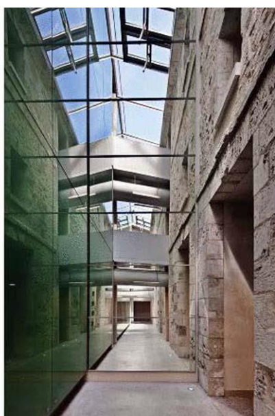
Рис. 4. Музыкальная школа в Лувье, пространство между историческим зданием и современным объемом
