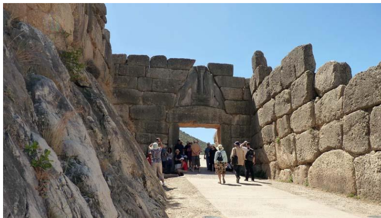
Рис. 16. Циклопическая кладка стен из огромных блоков. Микены
