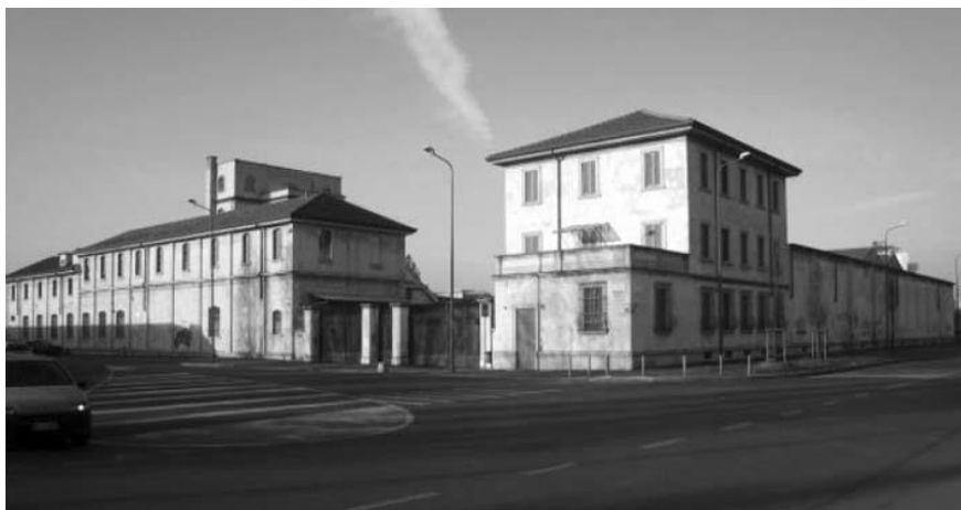
Рис. 15. Бывший спиртоводочный завод на Largo Isarco, 2. Вид до реконструкции
