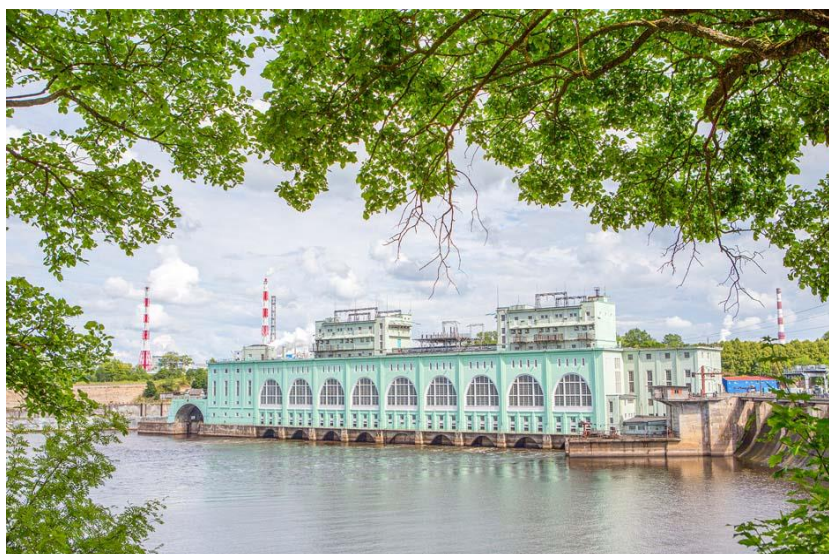
Рис. 2. Волховская ГЭС, г. Волхов, Ленинградская область, Россия
