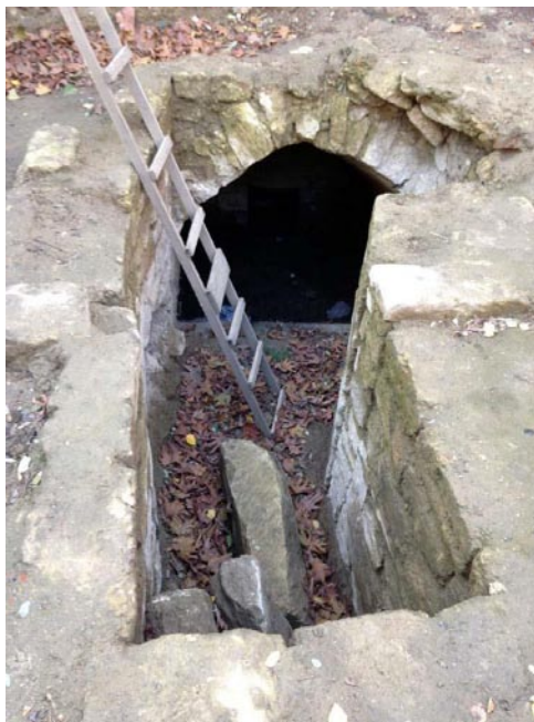
Рис. 4. Подземное водохранилище (овдан)
