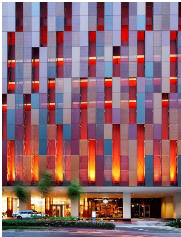
Рис. 14. Проект Luma от архитекторов Воха, Сингапур. Укрупненная сетка светового оборудования. Экранный фасад
