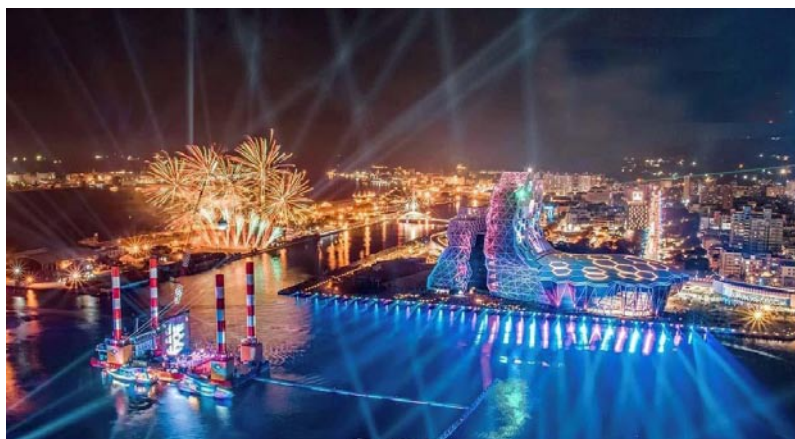
Рис. 9. Приморский Центр культуры и популярной музыки в заливе Гаосюн на Тайване. Архитектурное бюро Мануэль Монтезерин (Manuel Monteserín). Комплексное решение искусственного освещения объекта
