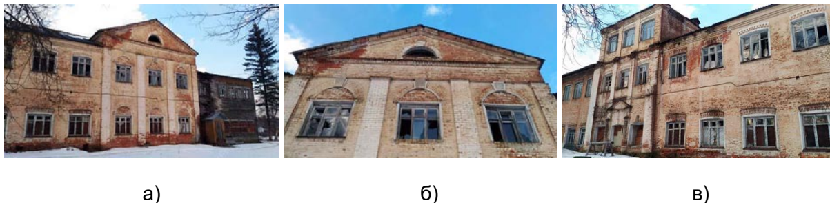
Рис. 13. Здания бывшей шелкопрядильной фабрики: а) часть южного фасада; б) фрагмент фасада, в) фрагмент южного фасада фабрики
