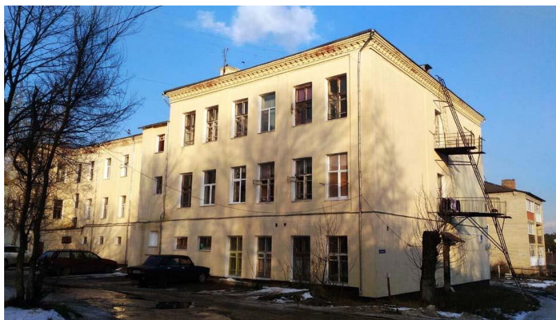
Рис. 12. Здание бывших жилых казарм для рабочих фабрики
