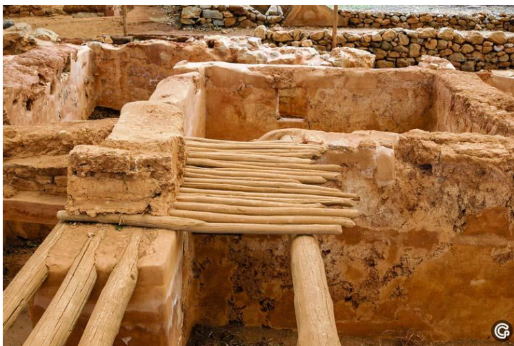
Рис. 11. Фрагмент восстановленного перекрытия во дворце в Малии
