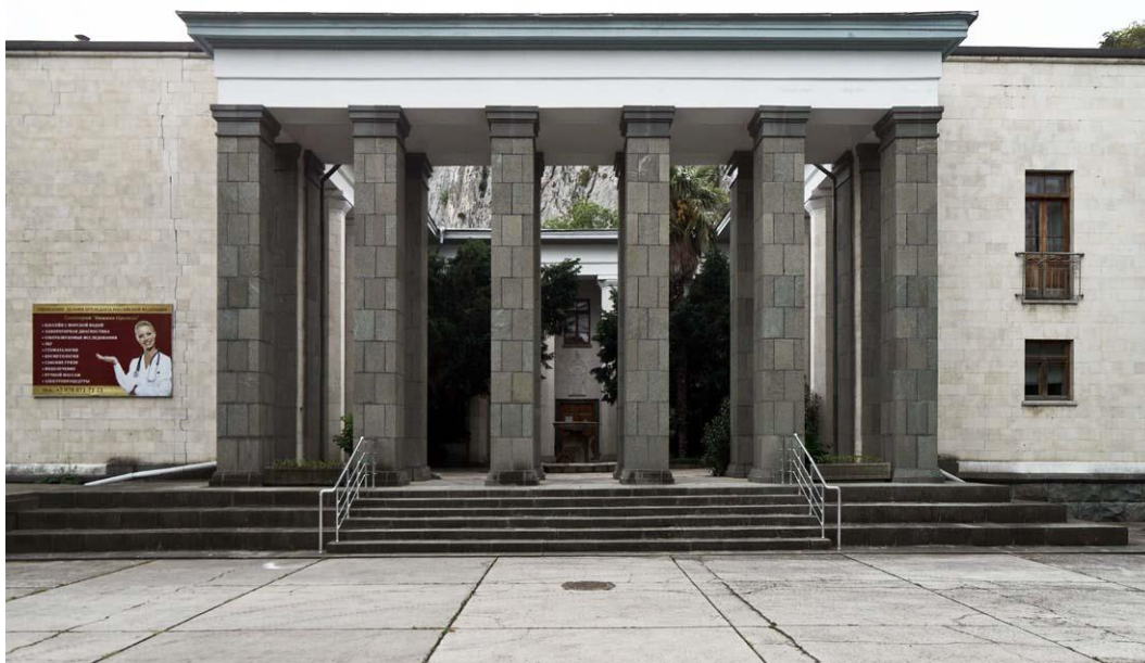
Рис. 8. Лечебный корпус. Вид с северной стороны
