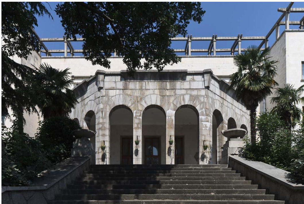
Рис. 4. Морской фасад корпуса «Б»
