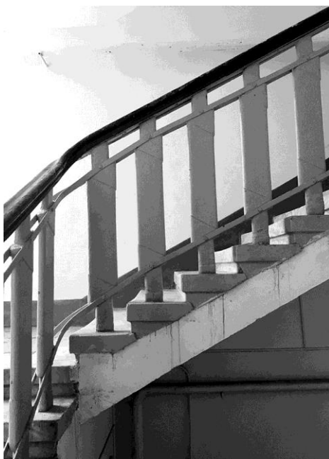
Рис. 7. Фрагмент стоек ограждения лестничной клетки (фото 2019 г.)
