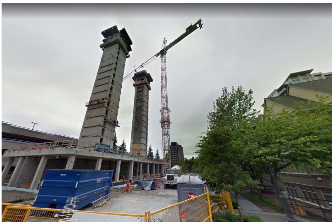
Рис. 1. Строительство Brock Commons Building в Ванкувере (дата съемки – май, 2016)
