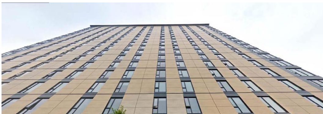
Рис. 2. Студенческое общежитие Университета Ванкувера Brock Commons Building (дата съёмки – июль, 2019)
