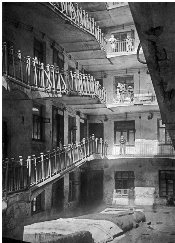
Рис. 10. Внизу видно покрытие пандуса, ведущего в подвал
