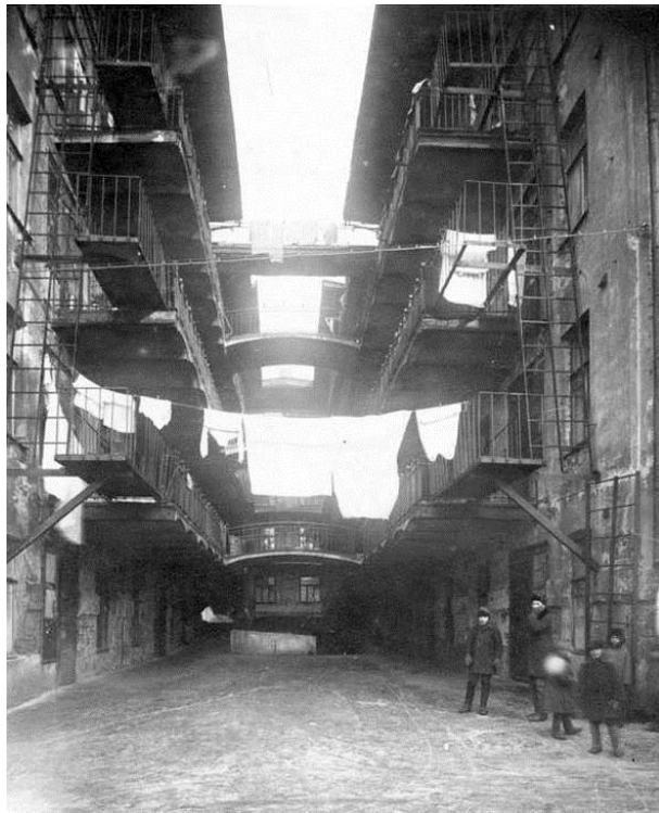
Рис. 9. Приставные лестницы в торцах галерей
