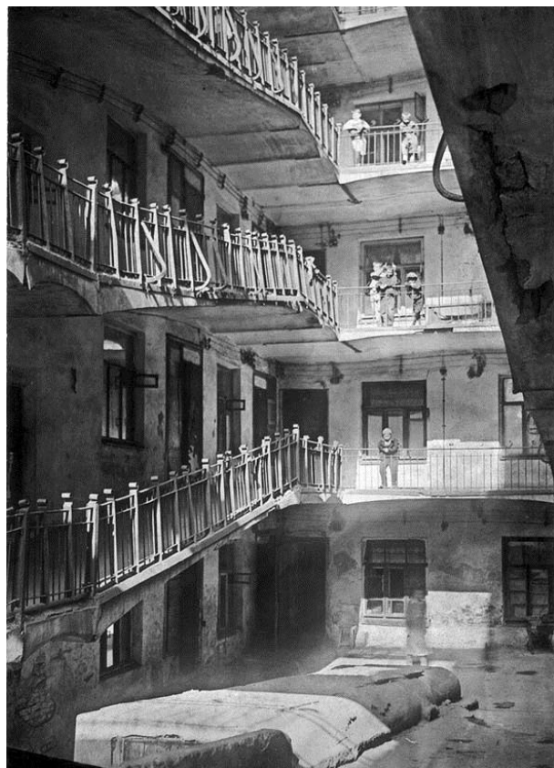
Рис. 10. Внизу видно покрытие пандуса, ведущего в подвал
