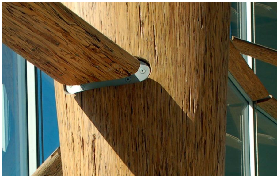
Рис. 4 Пиломатериалы с параллельными прядями (англ. Parallel-strand lumber , PSL)
