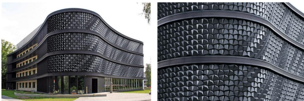
Рис. 6. Кинетический фасад здания кампуса Университета Южной Дании в Кольдинге с «умным» фасадом. Архитектурное бюро Henning Larsen Architects
