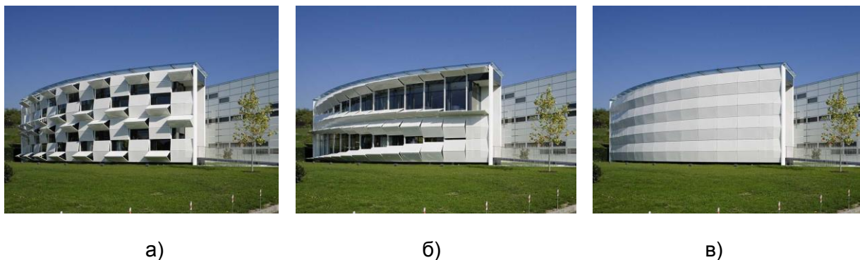
Рис. 8. Кинетический фасад офисного здания компании Kiefer Technic Architecture Showroom (архитектурная студия Ernst Giselsbrecht + Partner), 2012 г. (Австрия): а–в) варианты трансформации фасада
