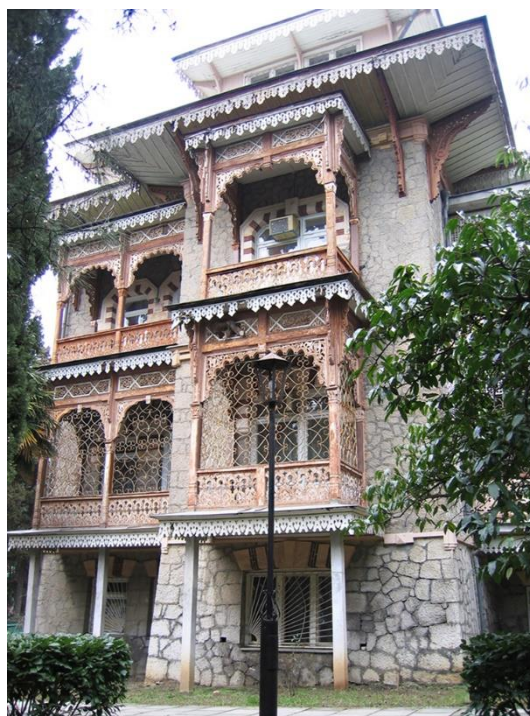
Рис. 2. Фрагмент фасада здания гостиничного комплекса П.И. Губонина в Гурзуфе. Фото автора, 2005 г.
