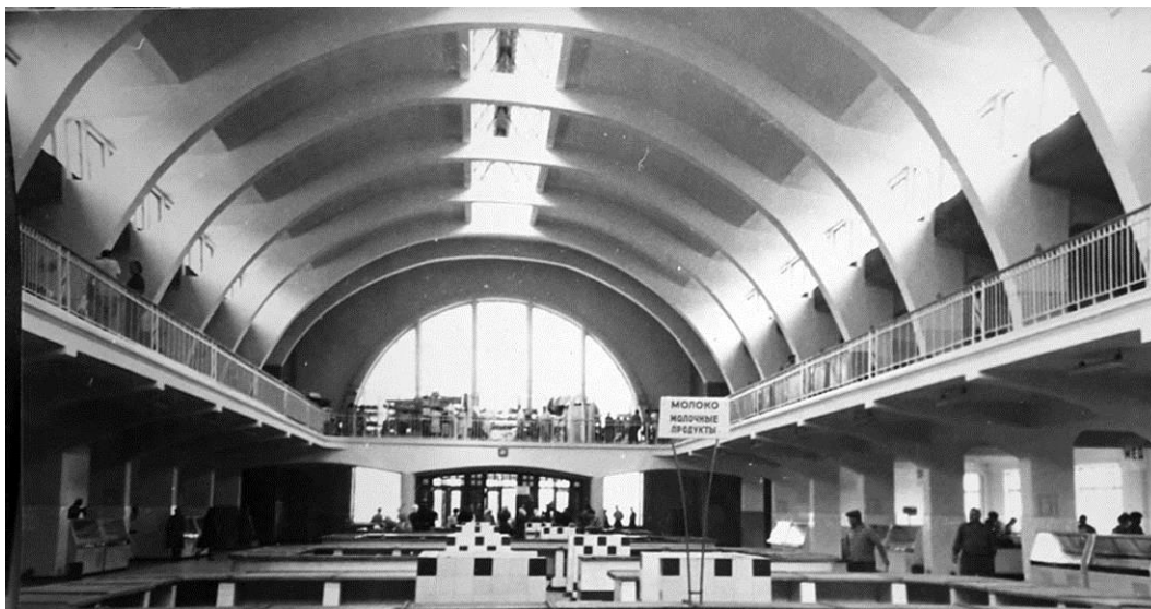
Рис. 8. «Пассаж». Фото интерьера. 1962 год (из архива архитектора А.Л. Шеффера)
