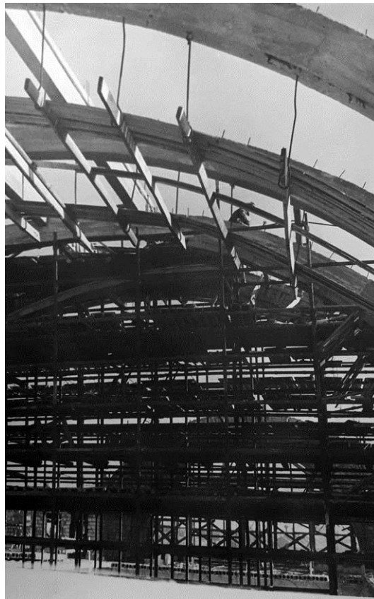
Рис. 7. «Пассаж» в ходе строительства. 1960 год (из архива архитектора А.Л. Шеффера)
