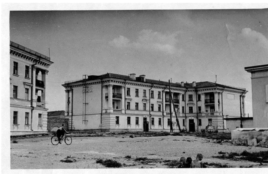
Рис. 2. Дома у Первой батареи. 1950 год (из архива архитектора А.Л. Шеффера)
