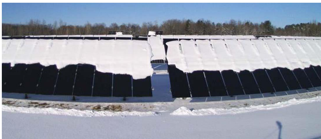
Рис. 3. Модули с каркасной и бескаркасной конструкцией сбрасывают снег примерно одинаково при температуре модуля чуть ниже 0^{\circ}\text{C} и температуре наружного воздуха -10^{\circ}\text{C} и ниже (по [23])
