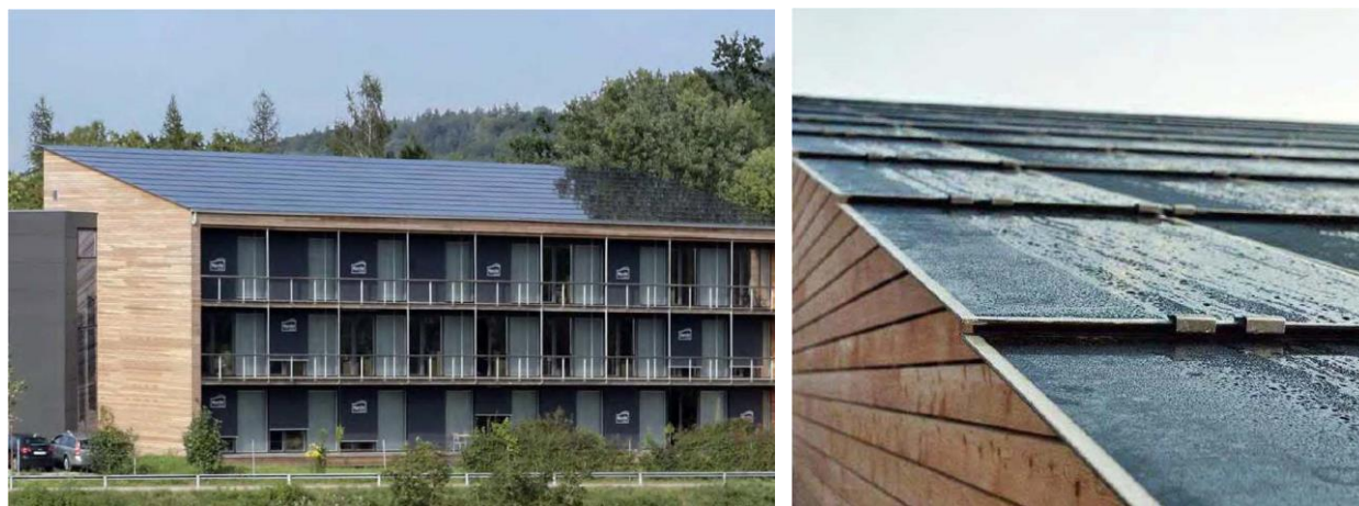
Рис. 2. ФЭУ, интегрированные в кровлю на архитектурном уровне VIP. Офисное здание «Marce International Support Office», г. Кемптхол, Швейцария. Архитектор Beat Kämpfen (по [22])
