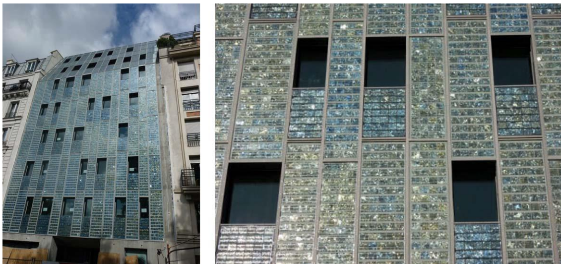
Рис. 5. Здание на набережной Вальми 179, Париж (Франция): семиэтажный фасад, покрытый 130 индивидуальными изумрудно-зелеными фотоэлектрическими панелями площадью 173,6 м 2 . Архитекторы Emmanuel Saadi и Jean-Louis Rey, 2011 (по [1])
