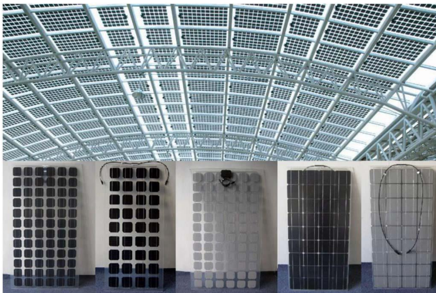
Рис. 6. ФЭУ в составе светопрозрачных элементов фасадов и покрытий зданий
