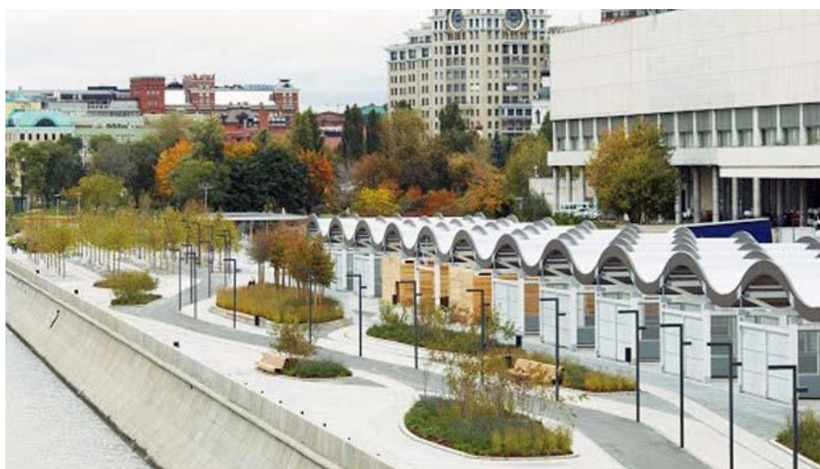
Рис. 17. Реконструкция Крымской набережной в Москве. 2013 г. Архитекторы Д. Ликин, О. Шапиро совместно с Е. Ассом и А. Андреевой
