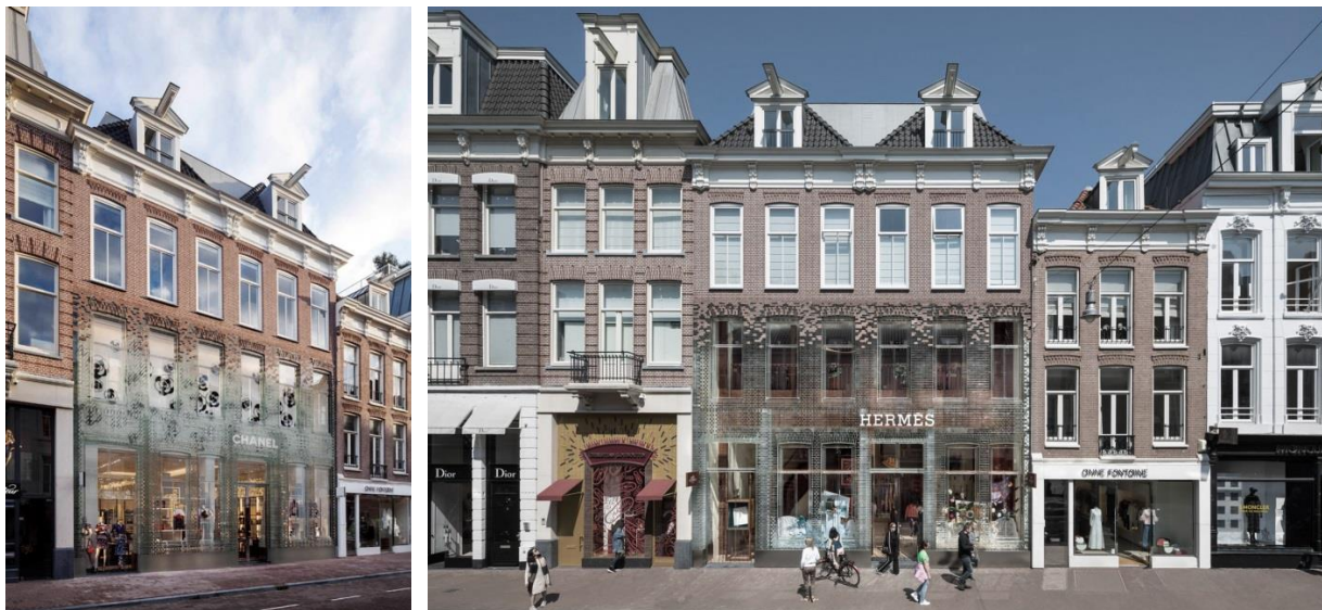
Рис. 3. Хрустальный дом в Амстердаме. Фасад фрагментарно выполнен из прозрачного кирпича. Архитектурное бюро MVRDV, 2016 г.
