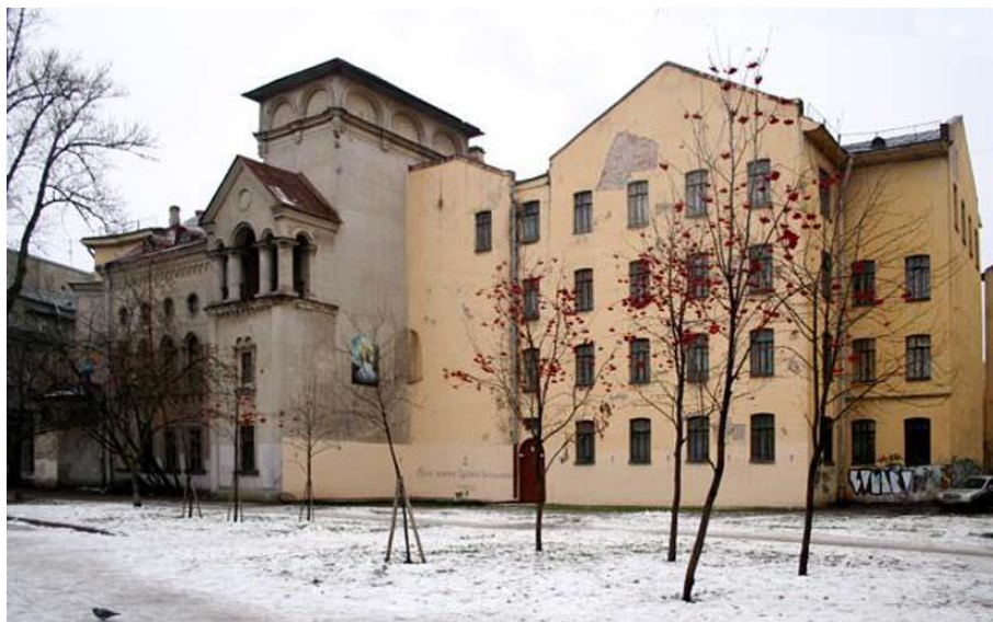
Рис. 5. Пристройка к основному корпусу приюта Во имя Царицы Небесной (современное состояние). Архитектор А.И. Балинский, 1913–1916 гг.
