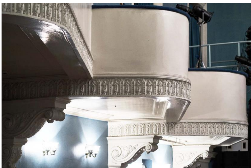
Рис. 13. Балконы в зрительном зале Матросского клуба (Драматического театра им. Б.А. Лавренева)
