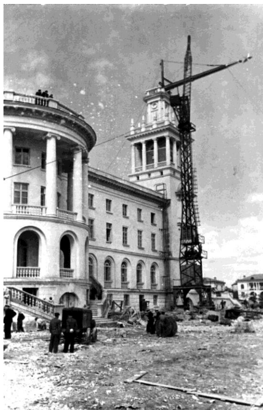
Рис. 3. Монтаж шпиля в ходе строительства Матросского клуба
