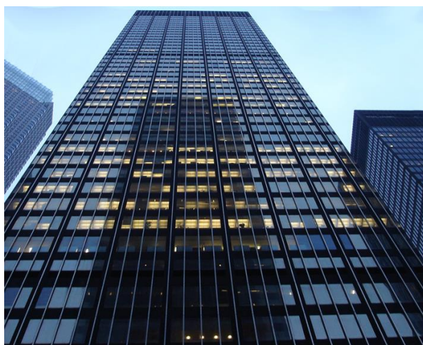
Рис. 1. Небоскреб на Манхэттене, подлежащий сносу
